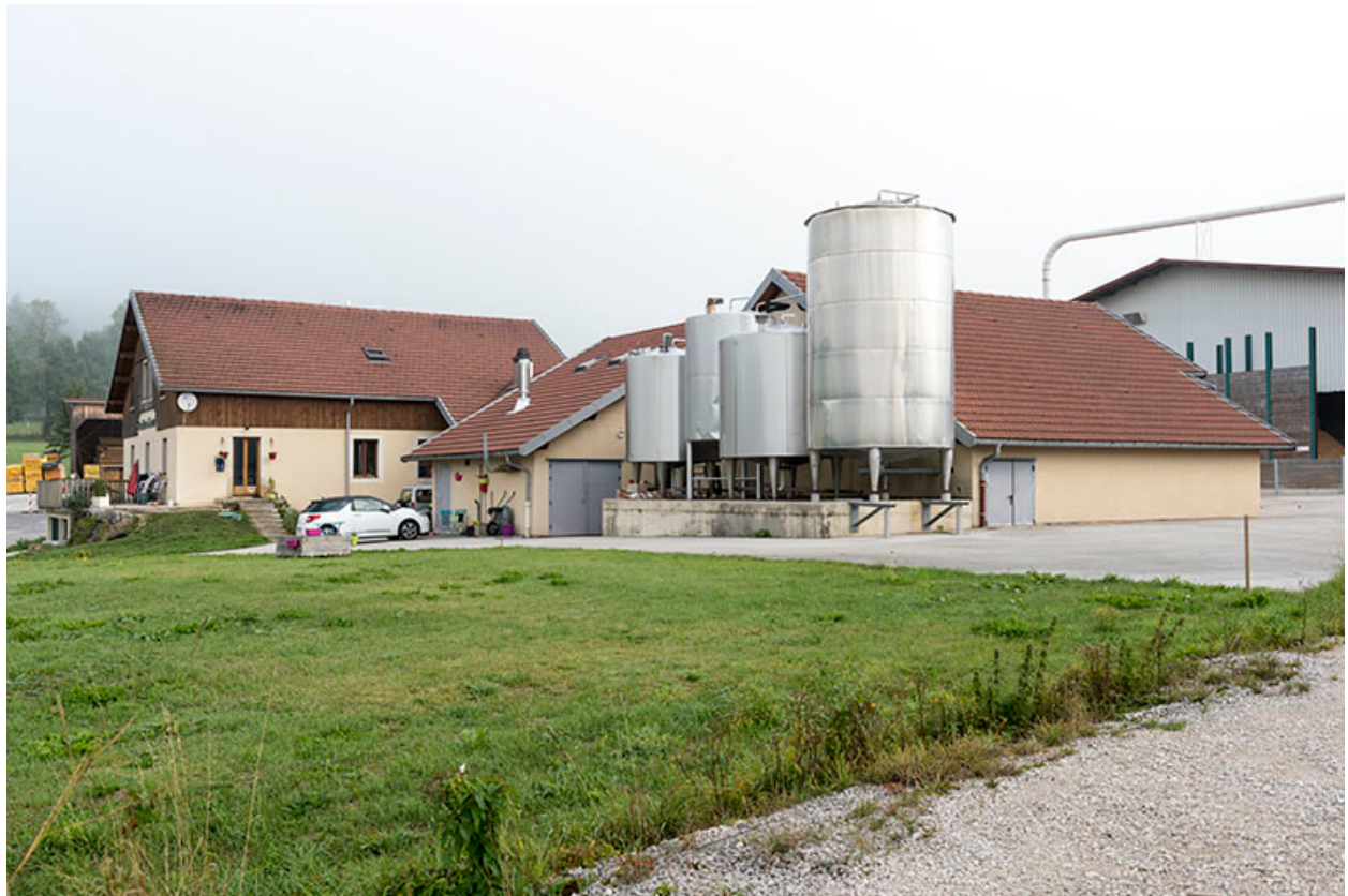
Vue d'ensemble, depuis le sud.
