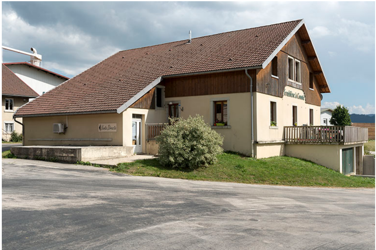
Façades postérieure et latérale droite.
