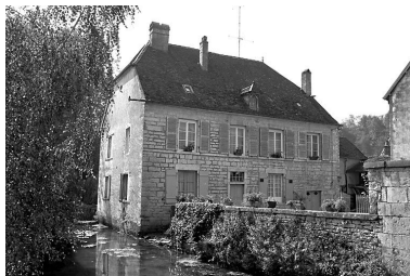
Façade antérieure de l'habitation. Phot. Yves Sancey IVR43_19777000223X
