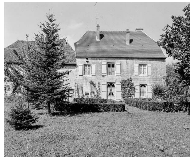
Façade postérieure de l'habitation. Phot. Yves Sancey IVR43_19777000224X
