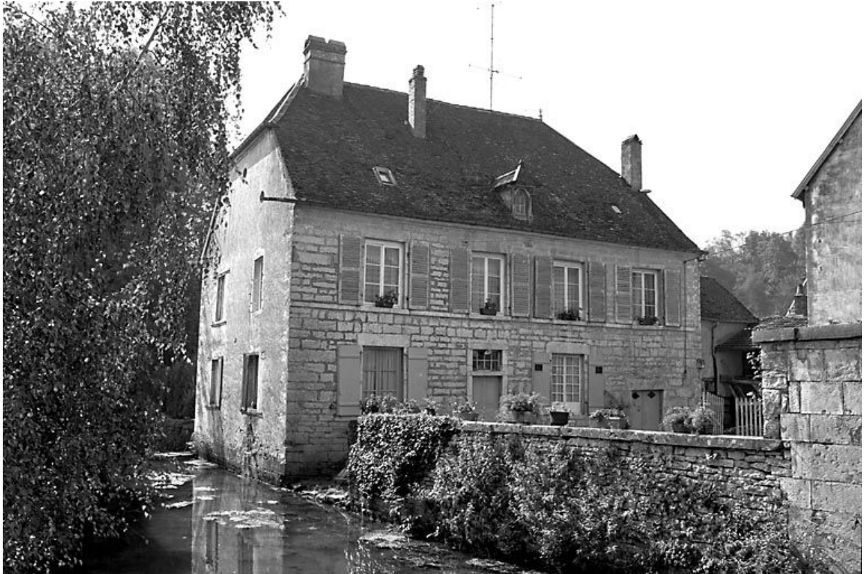
Façade antérieure de l'habitation.
