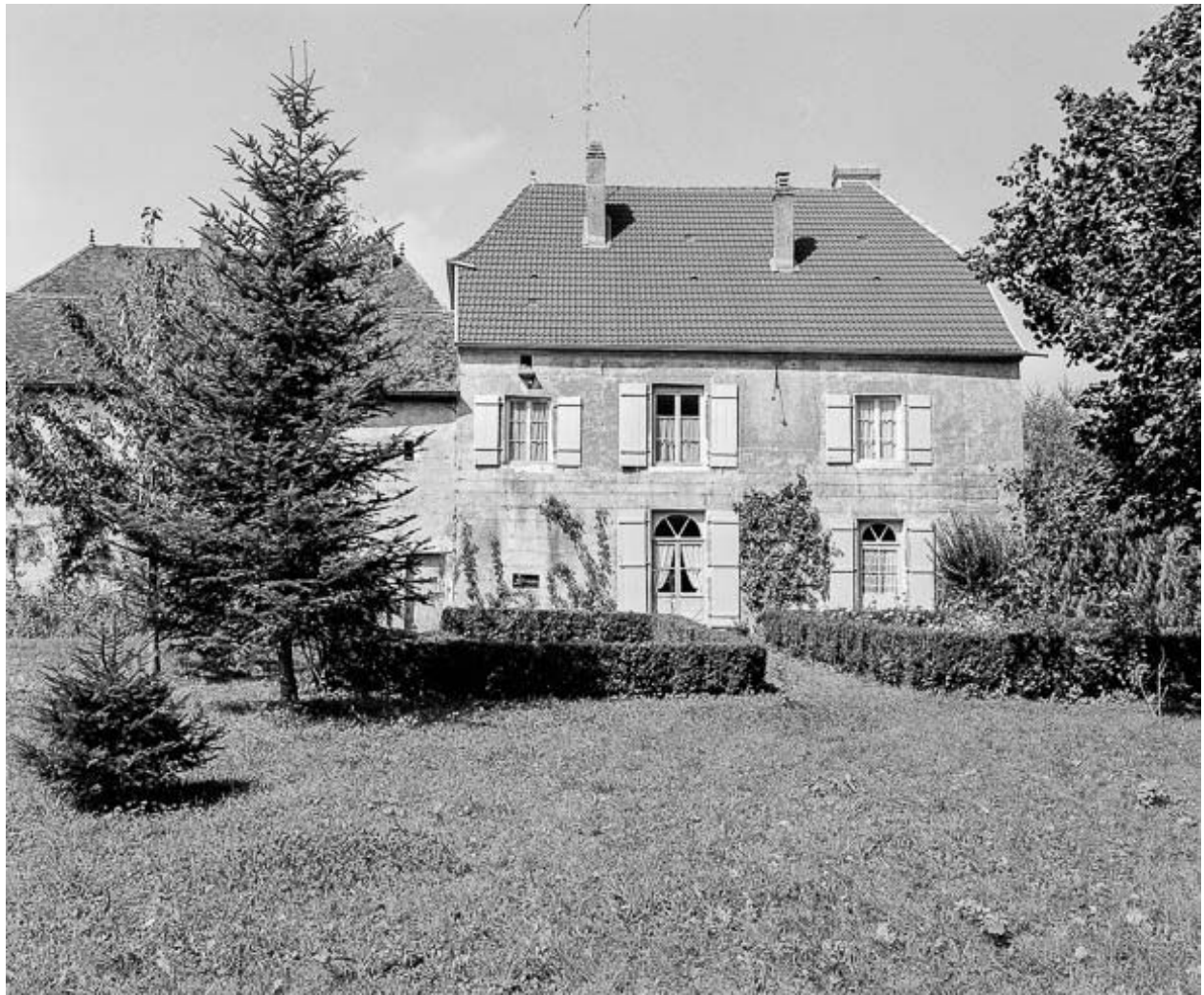
Façade postérieure de l'habitation.
