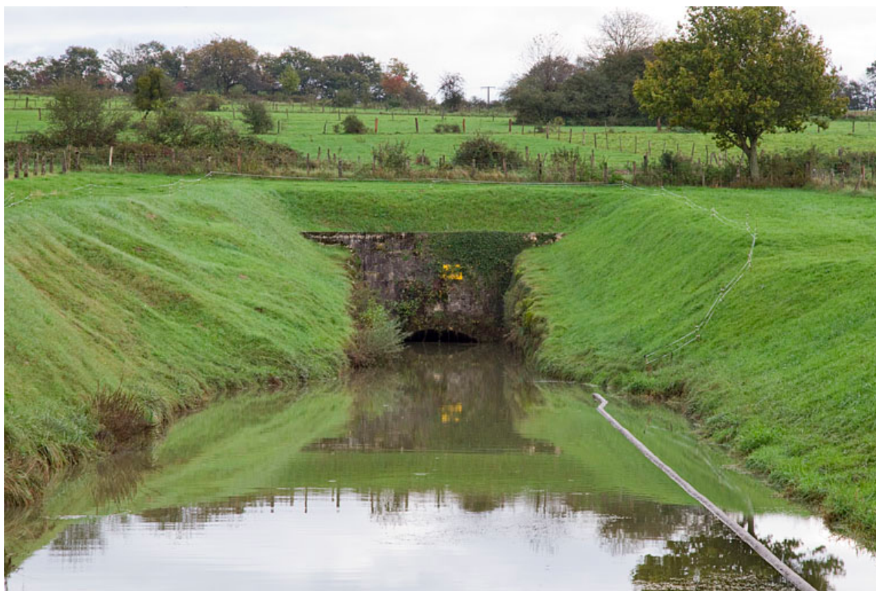
Bief d'amenée. Tête du tunnel.
