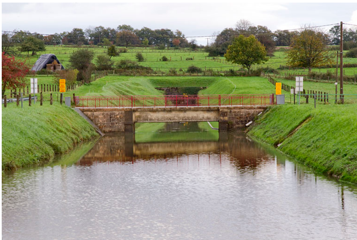
Pont routier sur le bief d'amenée.
