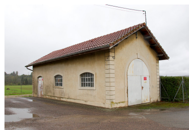
Atelier d'entretien. Phot. Yves Sancey IVR43_20122502070NUC2A
