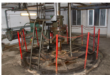
Partie supérieure d'une turbine et arbre de transmission vertical. Phot. Yves Sancey IVR43_20122502065NUC2A
