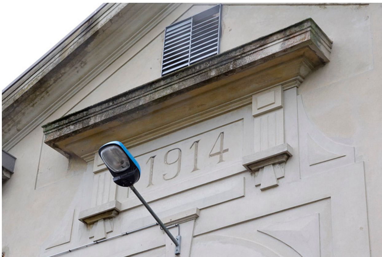
Cartouche de la façade nord.
