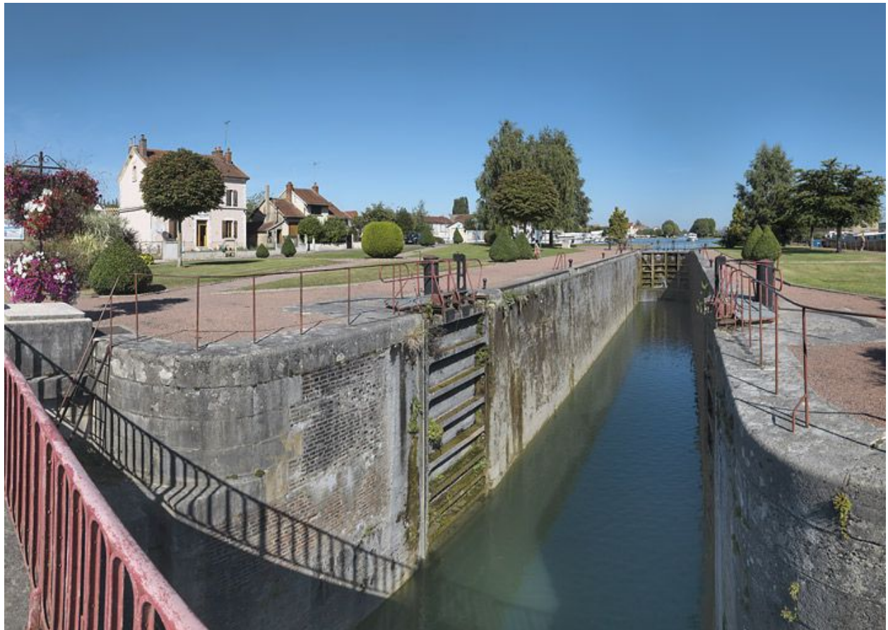
Site d'écluse vu d'amont : portes et bajoyers.
