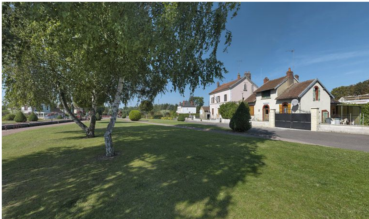
Site d'écluse vu d'aval.
