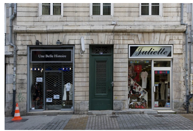
Détail du rez-de-chaussée de la façade sur rue. Phot. Yves Sancey IVR43_20082500282NUC2A
