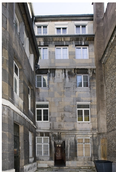
Vue d'ensemble de la façade postérieure du logis principal. Phot. Yves Sancey IVR43_20082500278NUC2A
