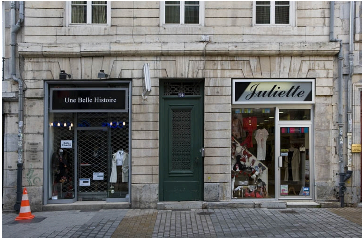
Détail du rez-de-chaussée de la façade sur rue.
