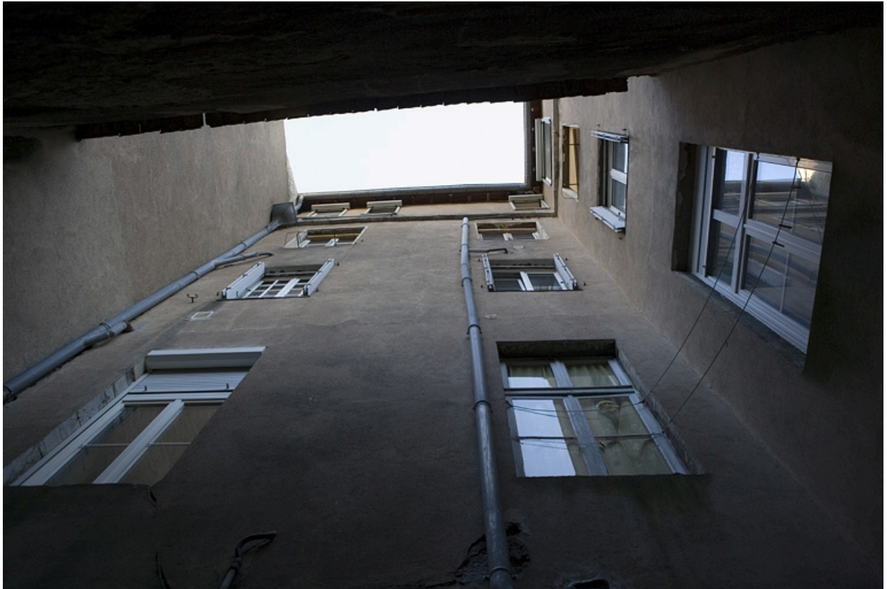
Vue des bâtiments en contre-plongée situés dans la deuxième cour.
