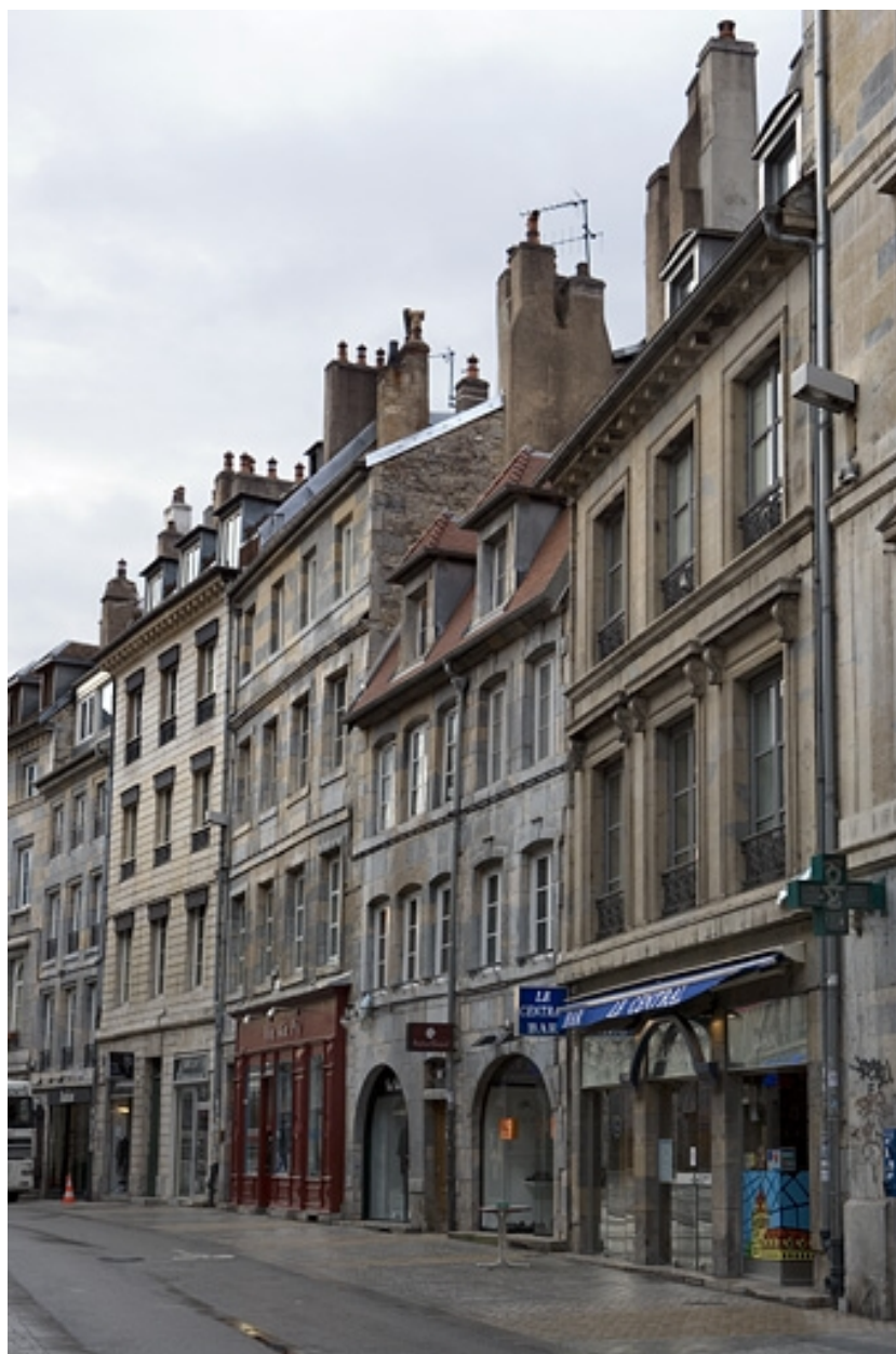
Vue éloignée de la maison dans l'alignement de la rue.
