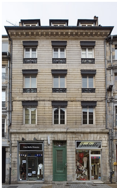
Vue d'ensemble de la façade sur rue, de face. Phot. Yves Sancey IVR43_20082500280NUC2A
