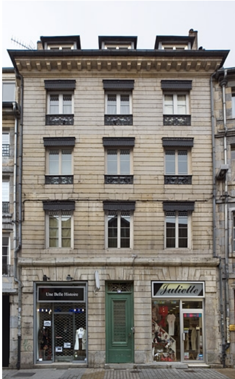
Vue d'ensemble de la façade sur rue, de face.
