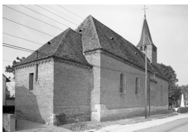
Chevet et élévation gauche Phot. Jean-Luc Duthu IVR26_19852100900V
