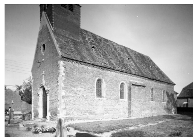
Elévations antérieure et droite Phot. Jean-Luc Duthu IVR26_19852100898V
