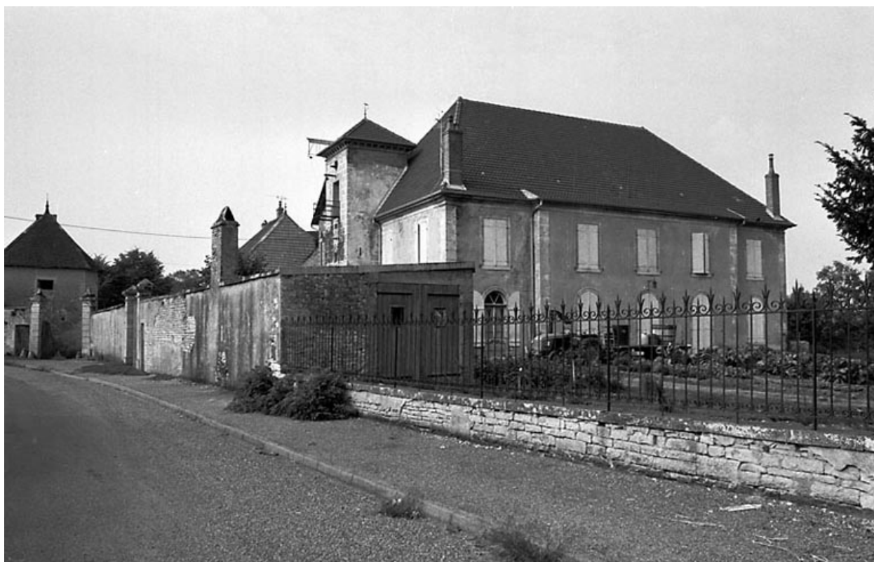
Vue d'ensemble depuis la rue.
