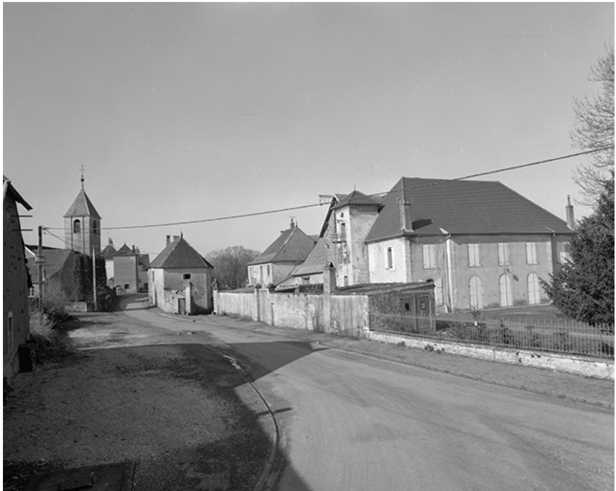
Vue d'ensemble depuis la rue.
