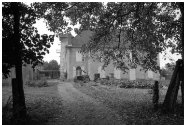
Demeure vue du parc. Phot. Bernard Lardière IVR43_19797000133Z
