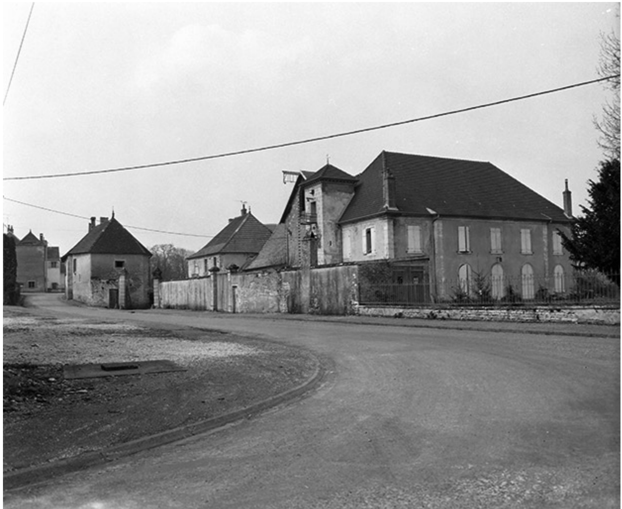
Vue d'ensemble depuis la rue.
