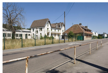
Logements, bureaux et conciergerie depuis l'ouest. Phot. Jérôme Mongreville IVR43_20067000640NUCA
