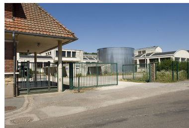
Vue depuis l'entrée. Phot. Jérôme Mongreville IVR43_20067000637NUCA
