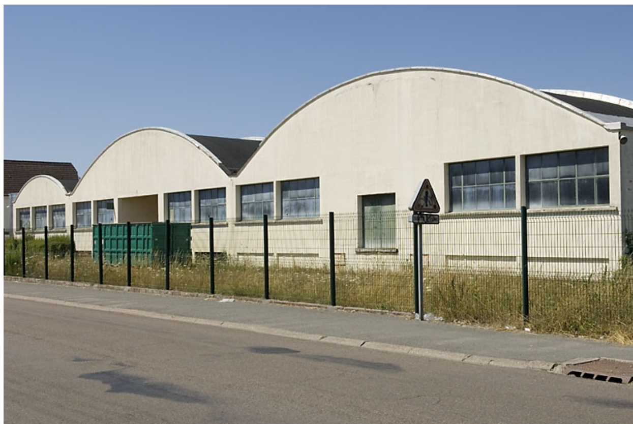
Murs-pignons sur la rue de la Viotte.
