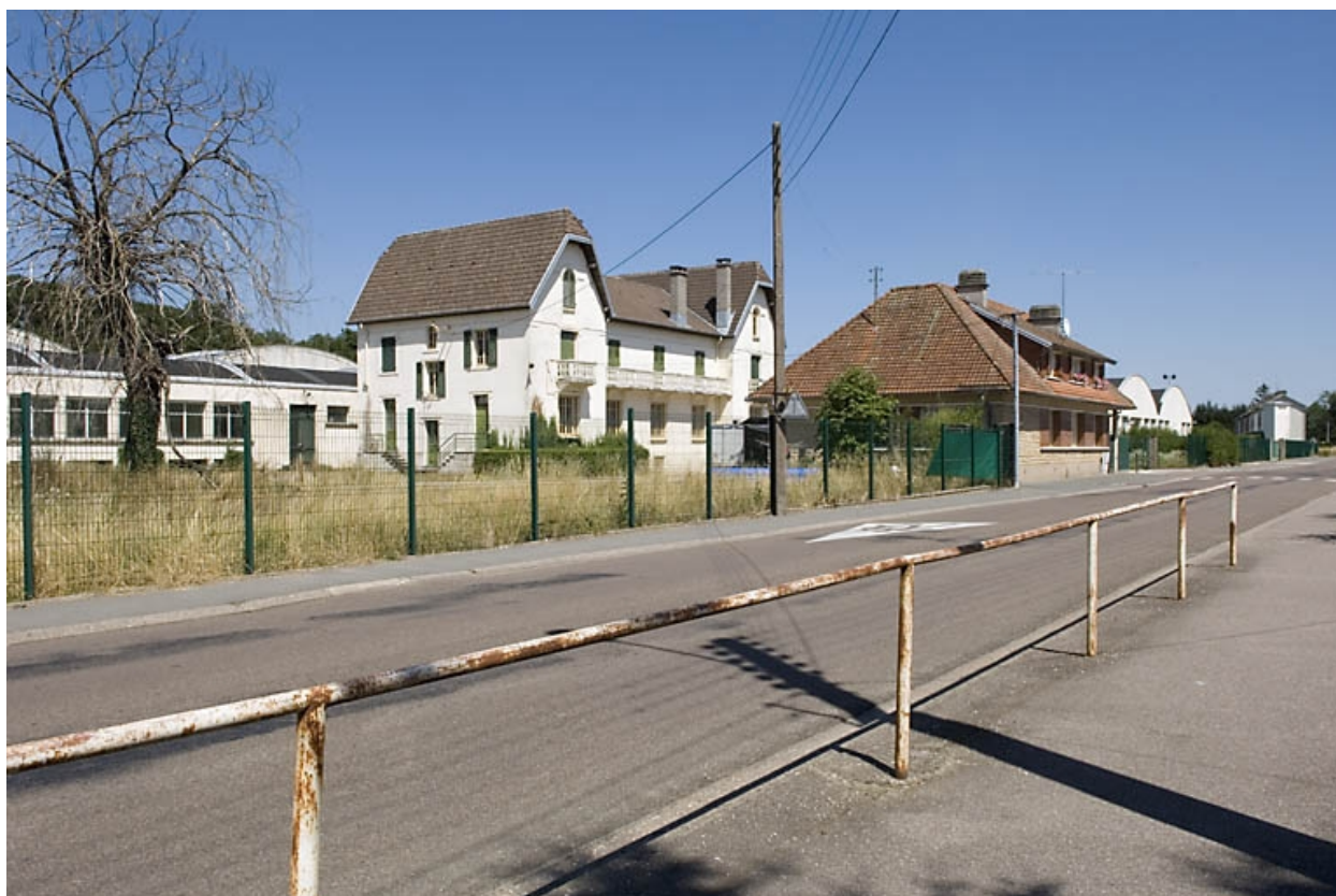
Logements, bureaux et conciergerie depuis l'ouest.
