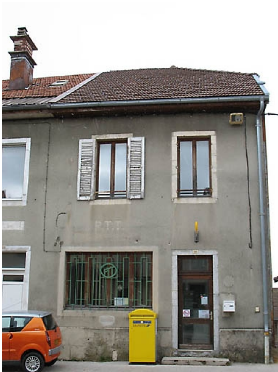
Vue générale de la façade antérieure.
