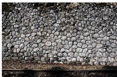
Tunnel du Chalet : appareil du mur en aile, côté La Cluse. Phot. Yves Sancey IVR43_20053900591ZA
