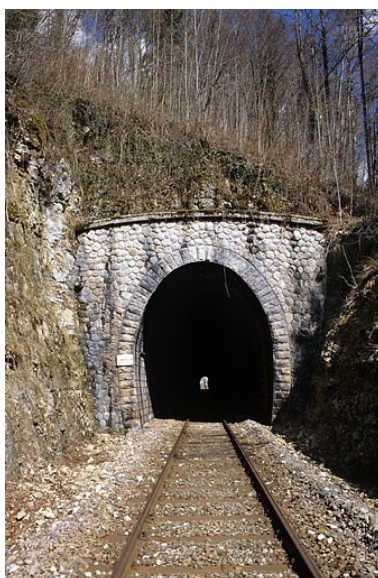
Tunnel du Grépillon : tête côté La Cluse (sud). Phot. Yves Sancey IVR43_20053900583ZA
