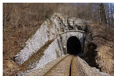
Tunnel du Chalet : vue d'ensemble, côté La Cluse (sud). A gauche, mur en aile sur deux niveaux. Phot. Yves Sancey IVR43_20053900587ZA
