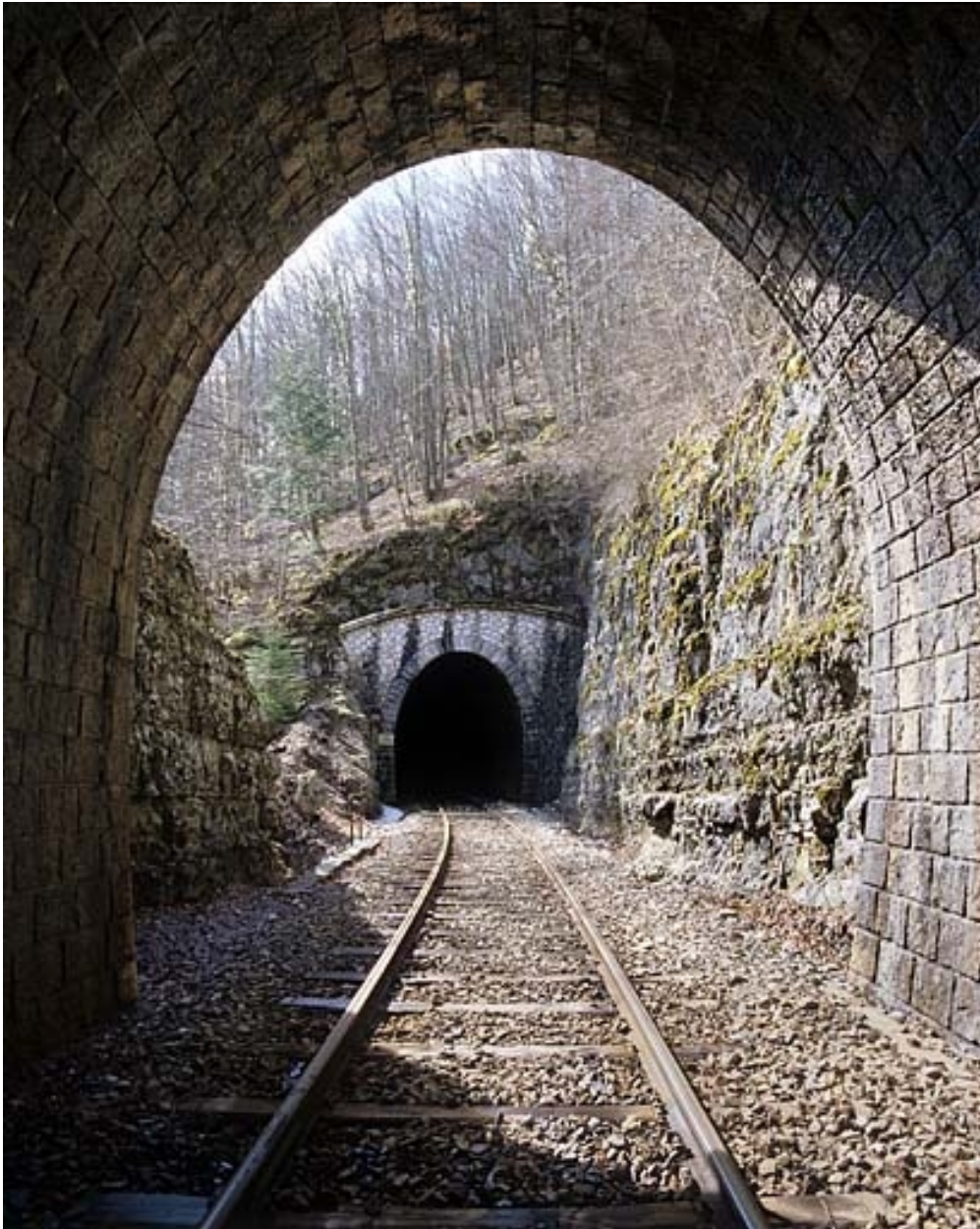
Tunnel du Grépillon : vue d'ensemble côté Andelot-en-Montagne (nord), depuis l'intérieur du tunnel de la Pointe.
