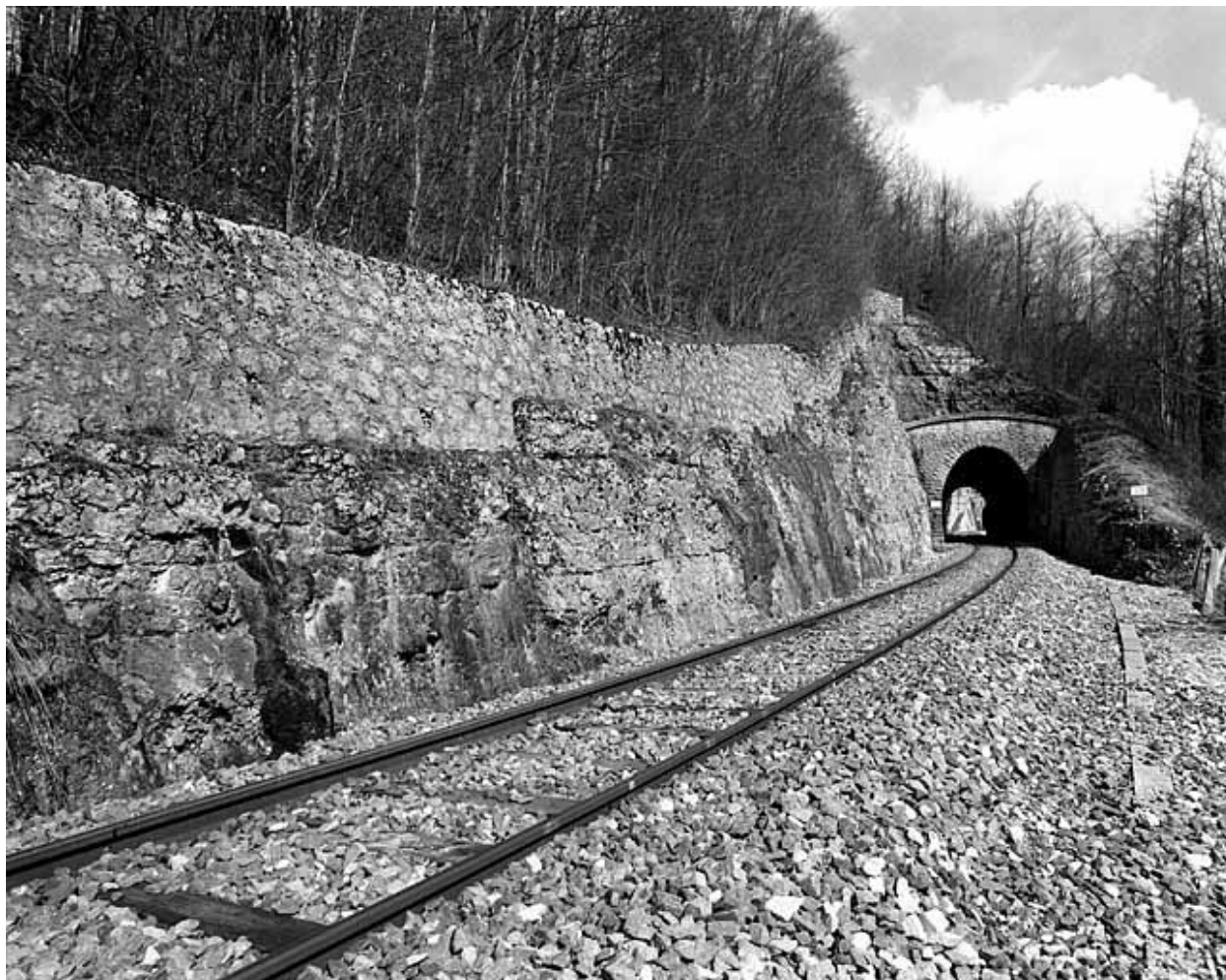
Tunnel de Tancua : vue d'ensemble, côté La Cluse (sud).
