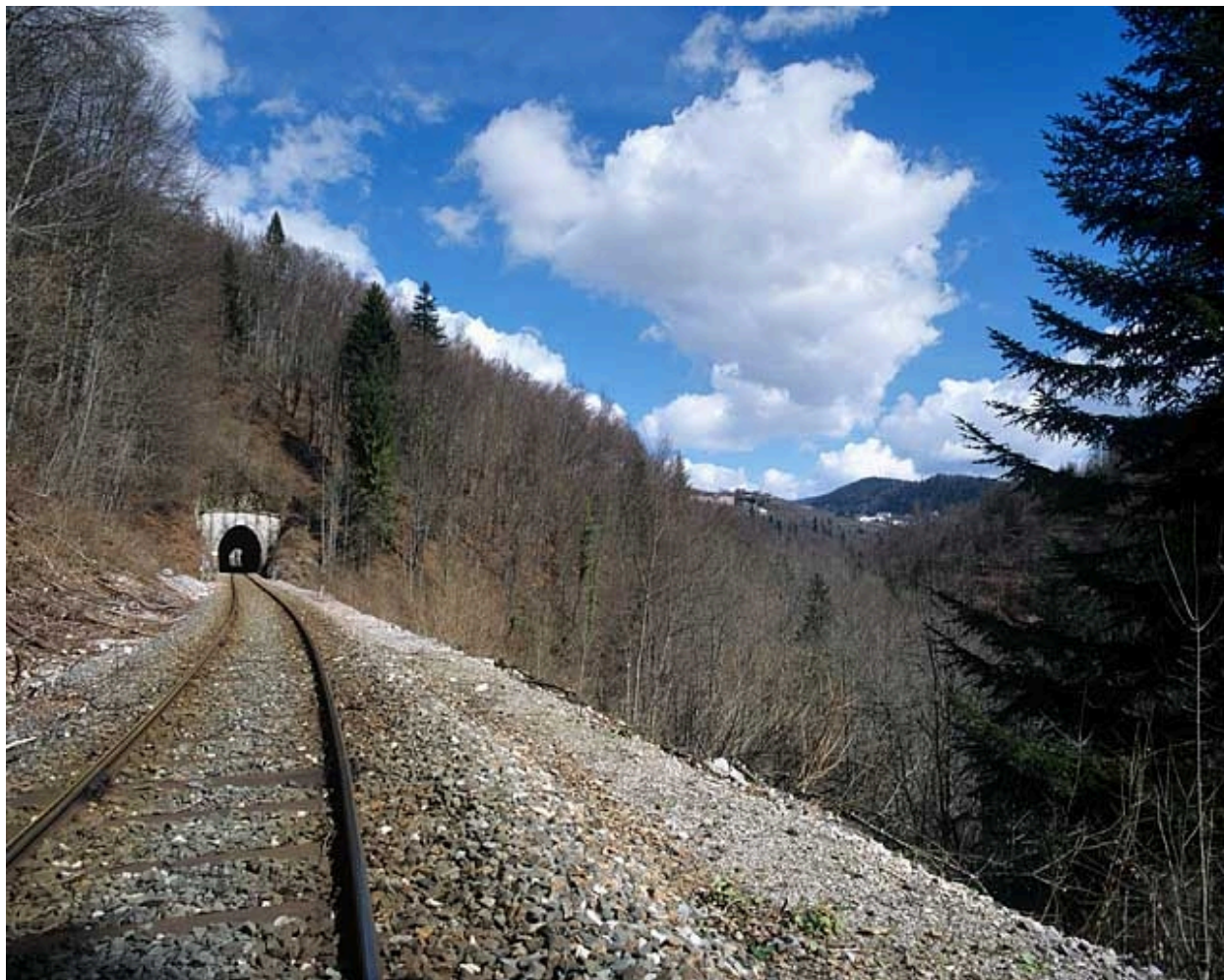
Tunnel du Grépillon : vue d'ensemble, côté La Cluse (sud).
