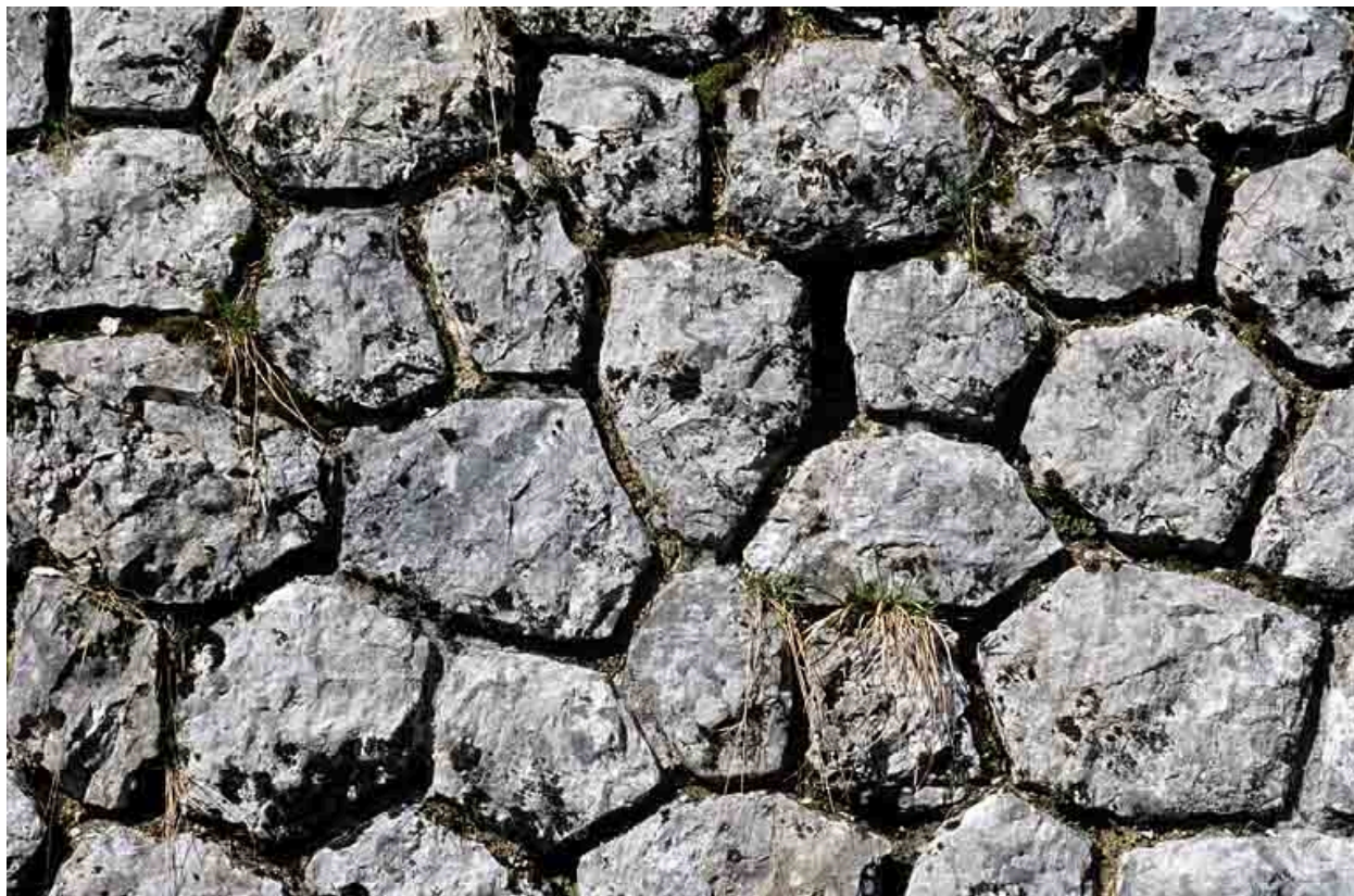
Tunnel du Chalet : détail de l'appareil du mur en aile, côté La Cluse.
