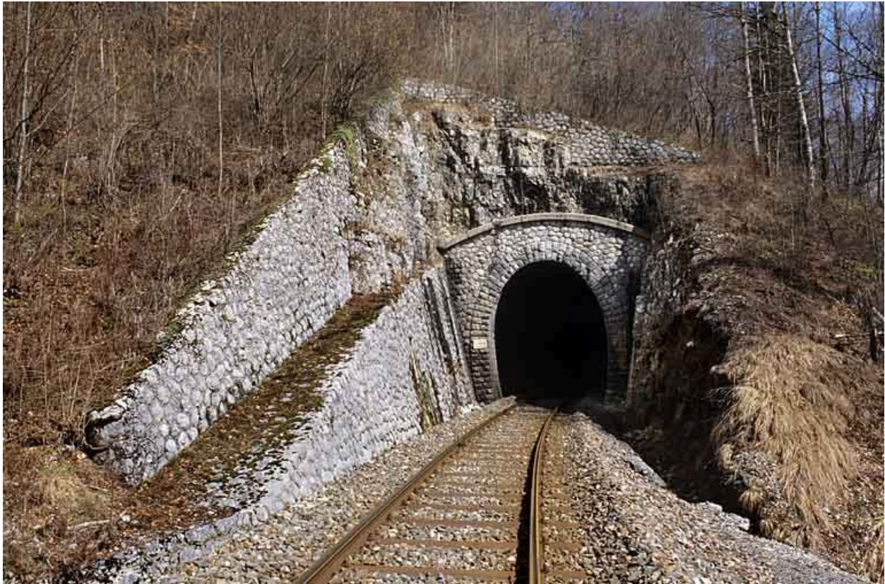
Tunnel du Chalet : vue d'ensemble, côté La Cluse (sud). A gauche, mur en aile sur deux niveaux.
