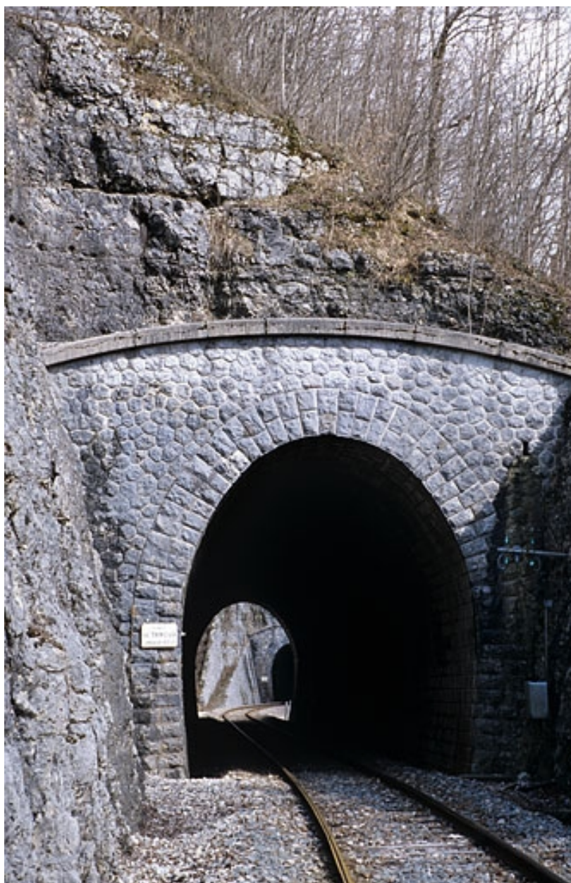
Tunnel de Tancua : tête côté La Cluse (sud).
