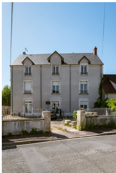
Façade depuis la rue de Bourgneuf. Phot. Pierre-Marie Barbe-Richaud IVR26_20205800526NUC4A
