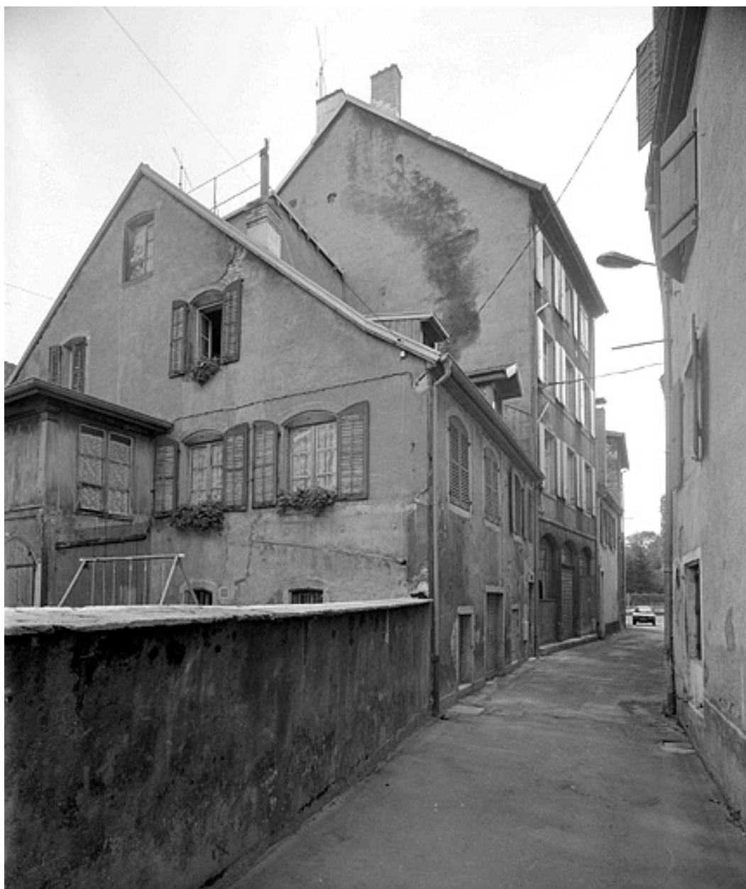
Façade sur la rue des Tanneries.
