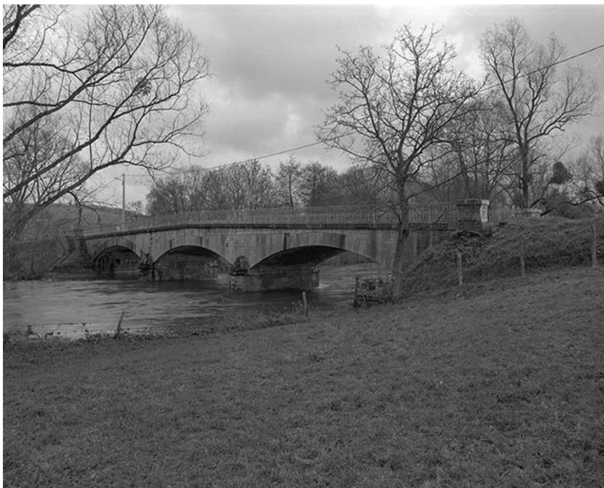
Vue d'ensemble prise de l'aval.
