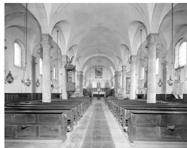
Nef et chœur. Phot. Yves Sancey IVR43_19782500108V
