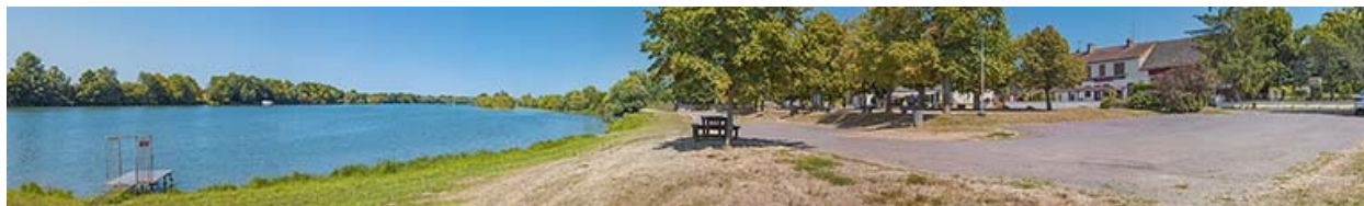
Vue d'ensemble du site du port d'Allériot.
