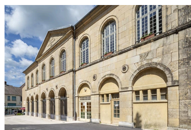
Vue de trois quarts droit de la façade antérieure de la halle. Phot. Jérôme Mongreville IVR43_20217000476NUC4A
