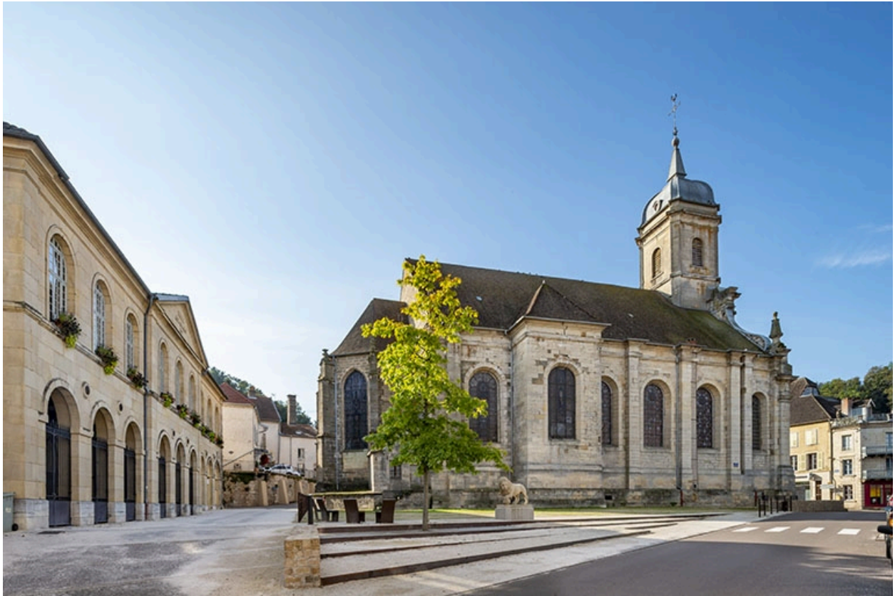
Vue éloignée, depuis le nord-ouest, de la façade antérieure de la halle et du côté nord de l'église.
