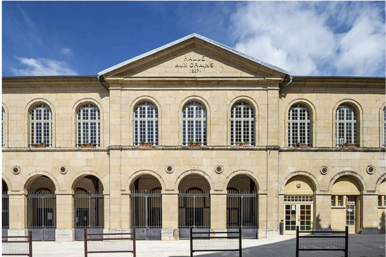
Détail de la vue de face de la façade antérieure de la halle.
