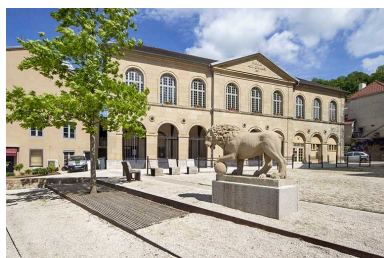
Vue éloignée de trois quarts gauche de la façade antérieure de la halle. Phot. Jérôme Mongreville IVR43_20217000477NUC4A
