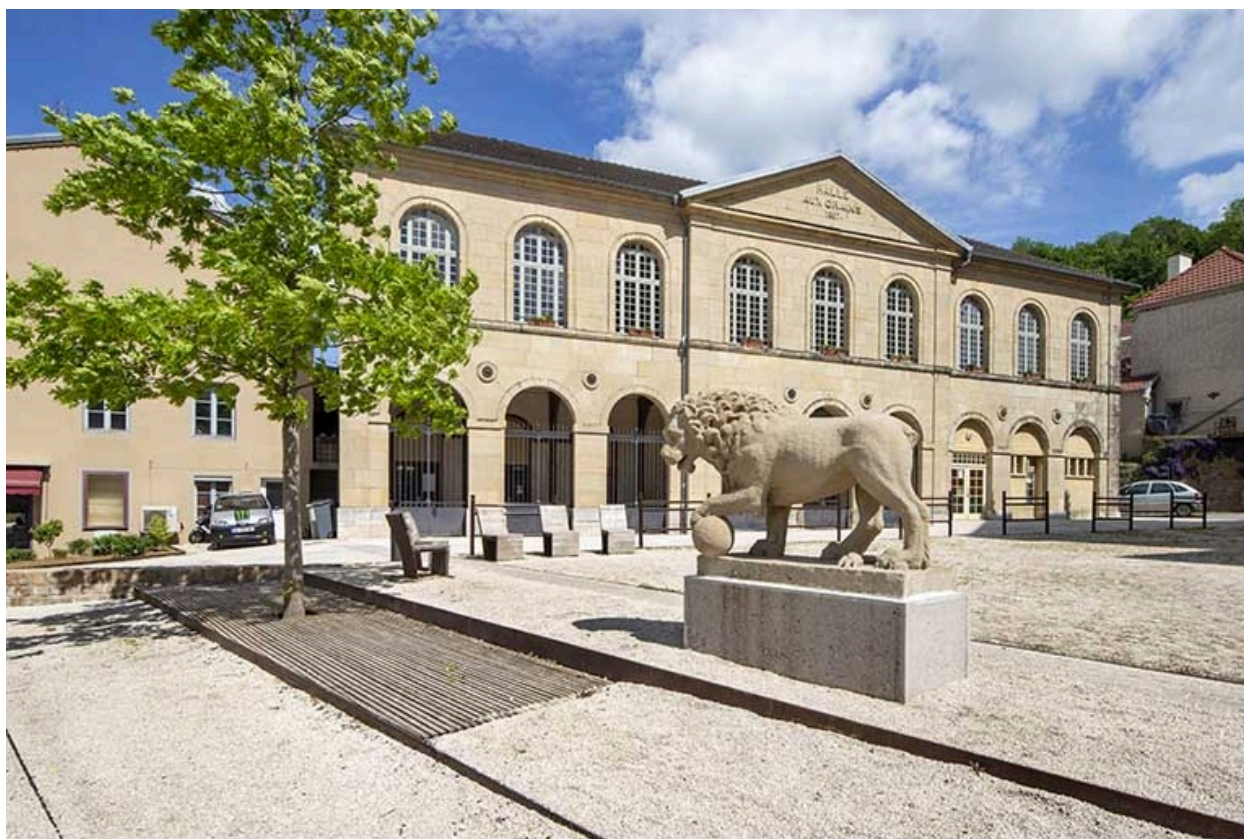
Vue éloignée de trois quarts gauche de la façade antérieure de la halle.
