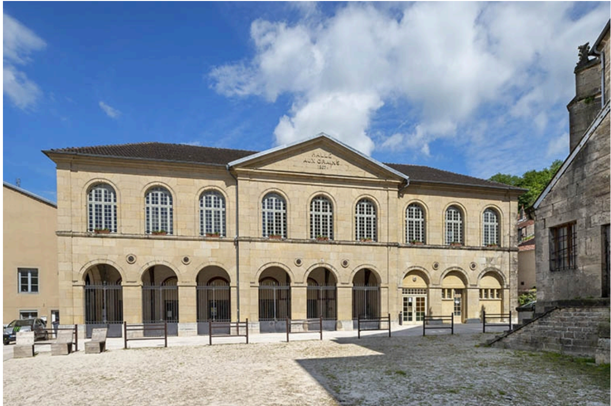
Vue de face de la halle.
