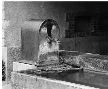
Détail de la borne-fontaine. Phot. Michel Rosso IVR26_19792101259X
