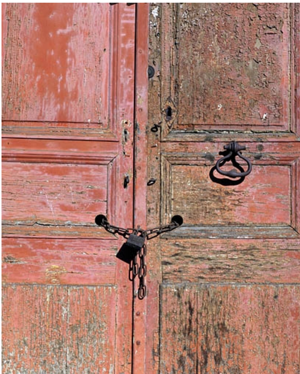
Entrée principale : détail des vantaux.
