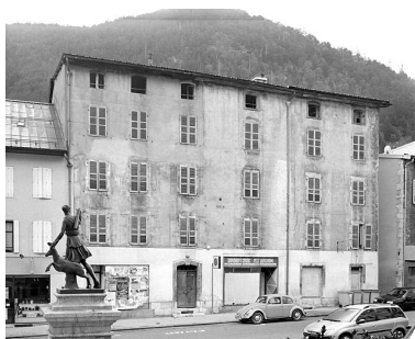
Elévation antérieure. Phot. Yves Sancey IVR43_20033900495X
