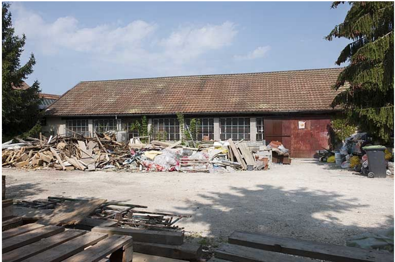
Façade sud de l'atelier de fabrication.
