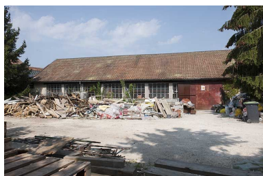
Façade sud de l'atelier de fabrication.
