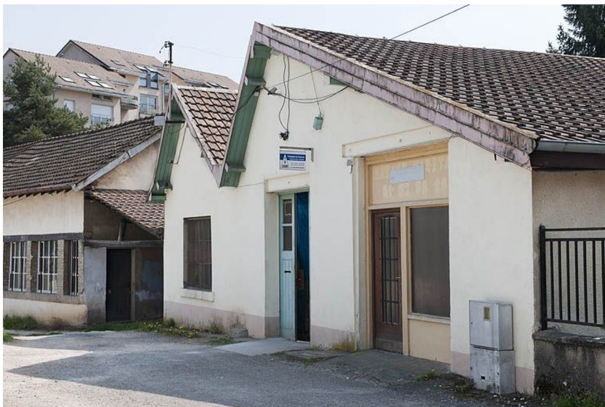
Ateliers de fabrication depuis l'ouest.
