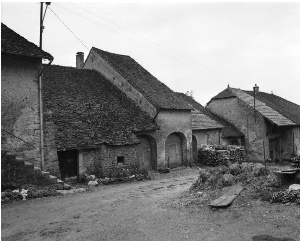
Ferme situées chemin des Vignes : façades sur rue.
