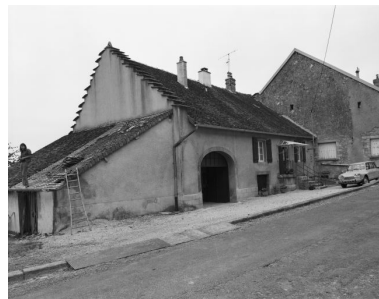
Ferme située rue de l'Eglise : vue d'ensemble.
