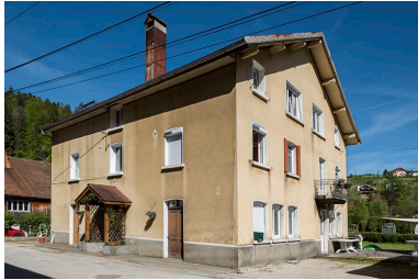
Fonderie : façades antérieure et latérale droite.
