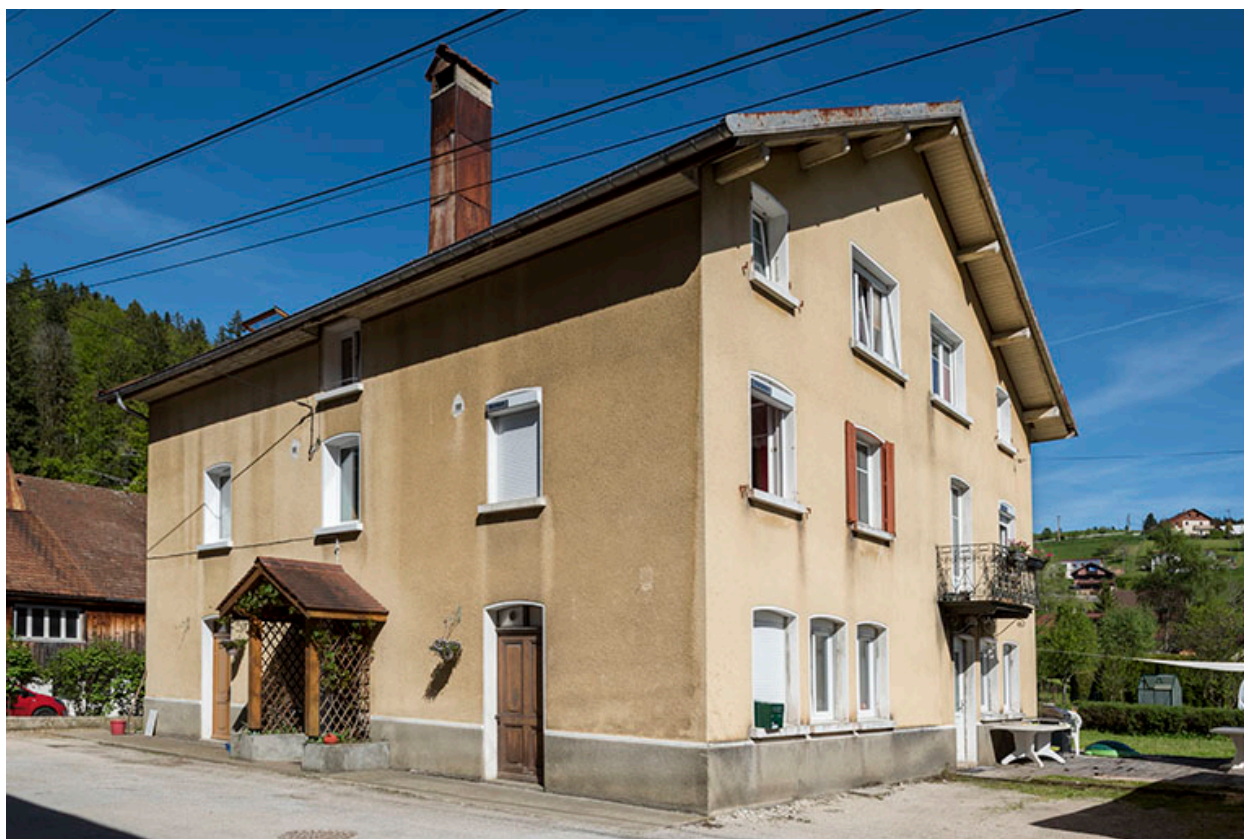
Fonderie : façades antérieure et latérale droite.
