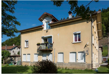
Fonderie : façade postérieure, de trois quarts droite.
