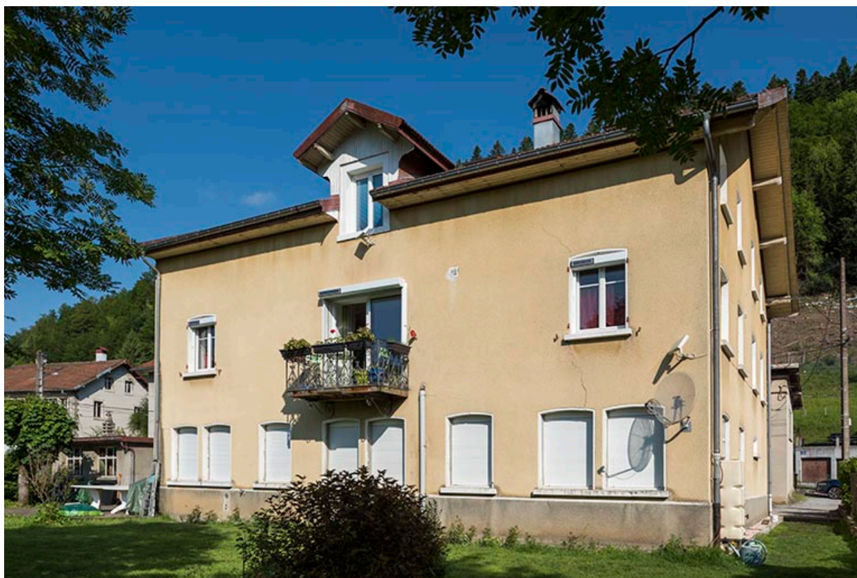
Fonderie : façade postérieure, de trois quarts droite.
