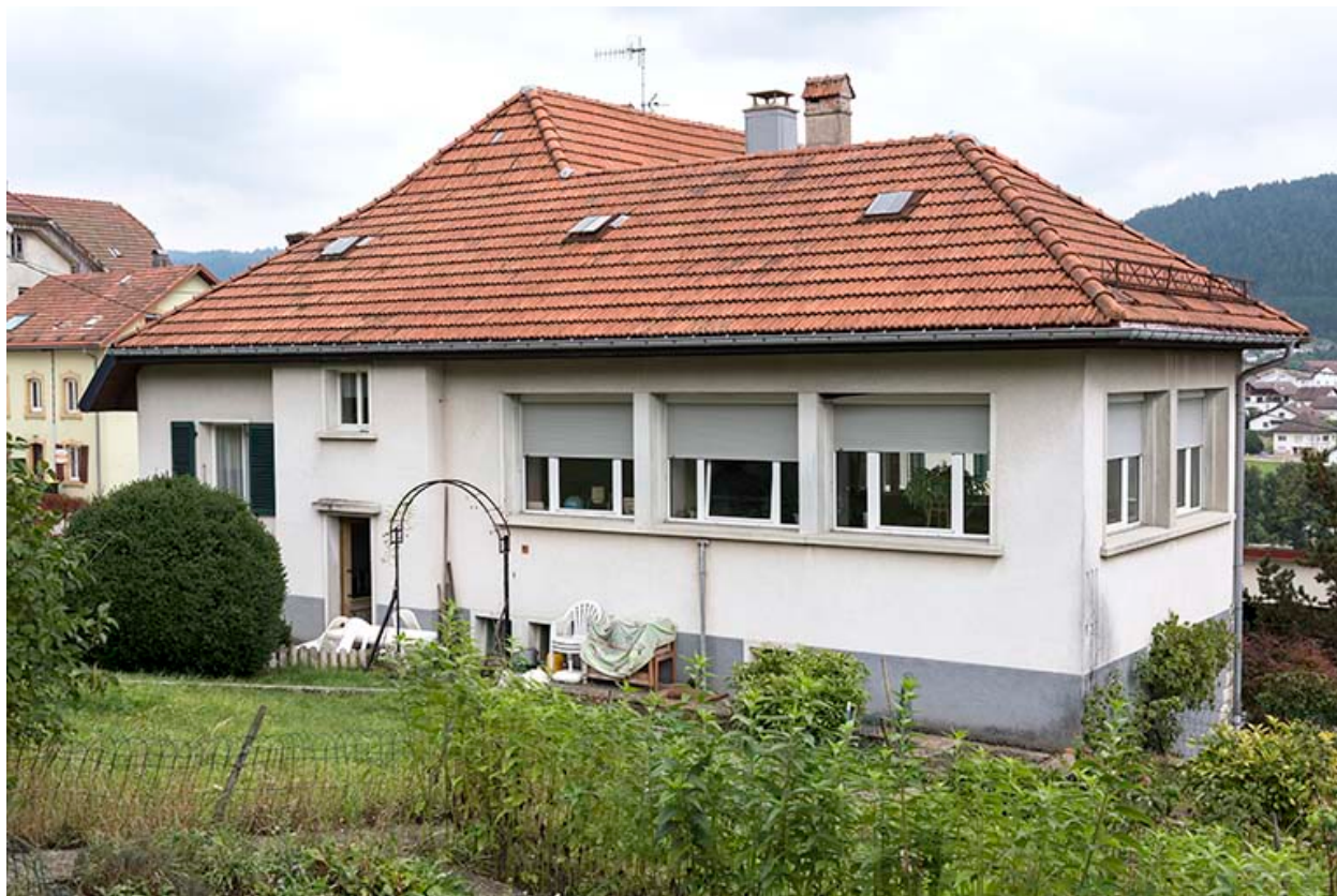
Façades postérieure et latérale gauche.
