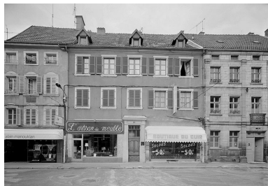
Façade sur rue. Phot. Jérôme Mongreville IVR43_19872500291V
