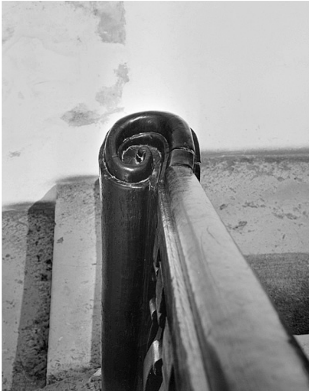
Détail du départ de la rampe d'appui.
