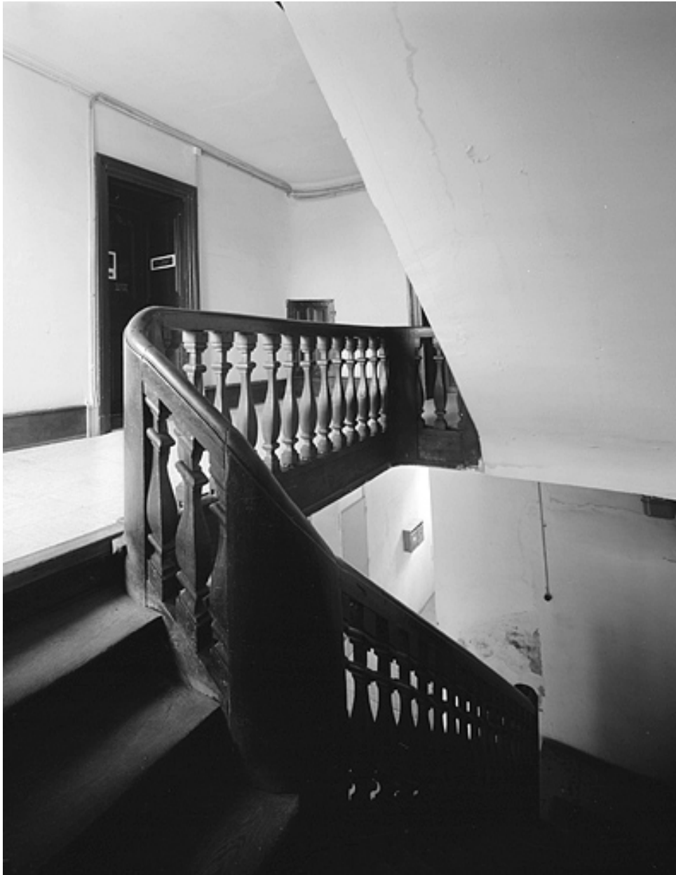
Escalier et palier du premier étage.
