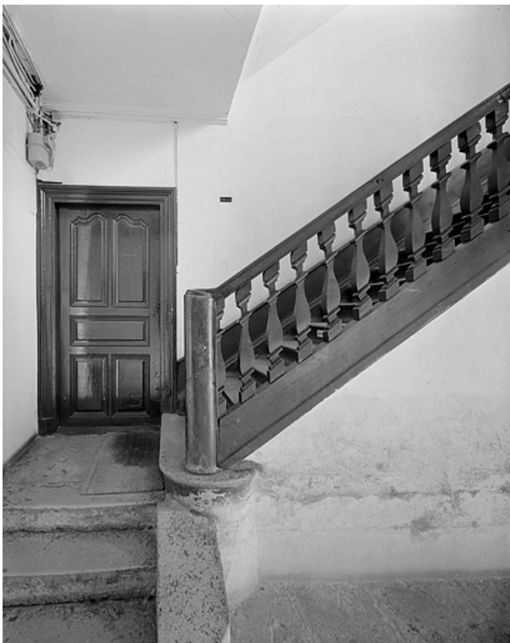
Escalier au niveau du rez-de-chaussée.
