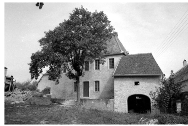
Vue d'ensemble, éloignée, de la maison d'habitation. Phot. Bernard Lardière IVR43_19797000014Z
