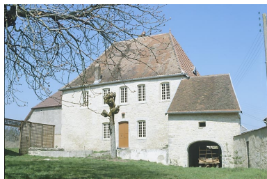
Vue d'ensemble éloignée de la maison d'habitation. Phot. Yves Sancey IVR43_19827000500XA
