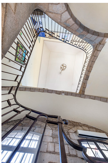
Ancien tribunal. Vue en contre- plongée de la cage d'escalier. Phot. Jérôme Mongreville IVR43_20233900763NUC4A
