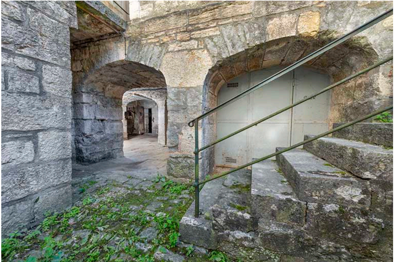
Cour ouest. Accès aux cellules de prison.
