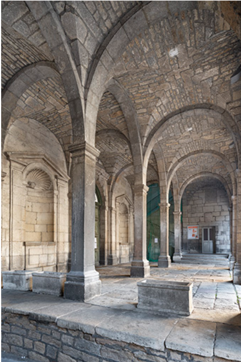
Parvis de la chapelle (et voûtement du rez-de-chaussée). Vue de trois quarts.
