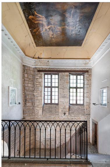
Aile nord. Cage d'escalier de la mairie. Phot. Jérôme Mongreville IVR43_20233900784NUC4A
