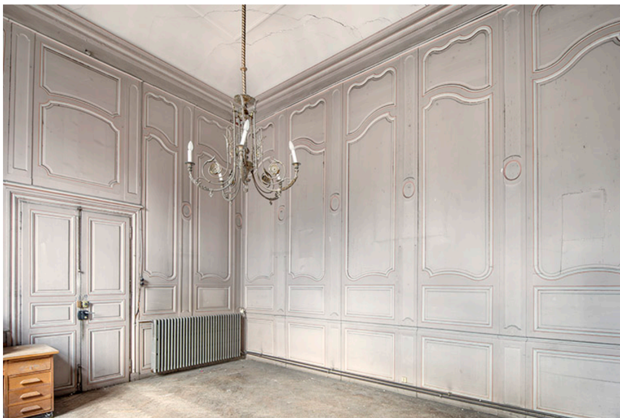
Aile nord. Pièce au premier étage, vue de trois quarts.
