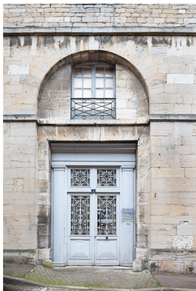
Porte de l'aile nord. Phot. Jérôme Mongreville IVR43_20243901090NUC4A
