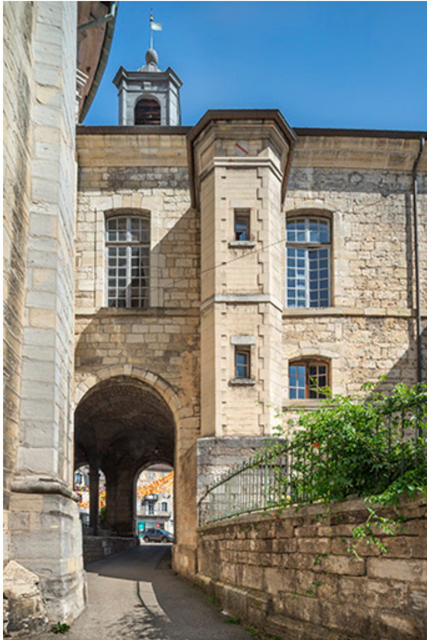
Elévation de la partie sud. Tour d'escalier hors-oeuvre.
