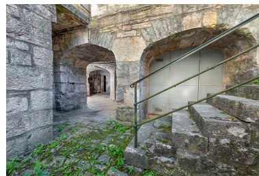
Cour ouest. Accès aux cellules de prison. Phot. Jérôme Mongreville IVR43_20233900781NUC4A
