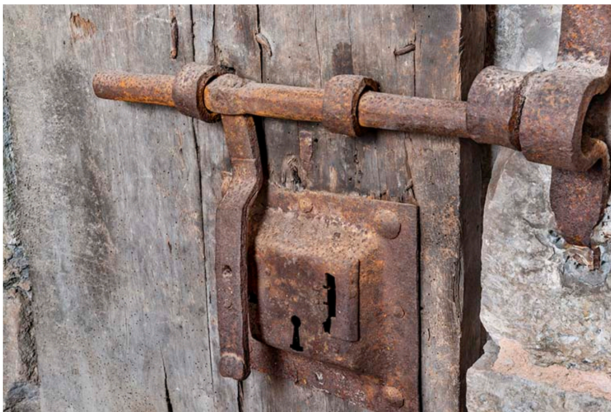
Porte de cellule. Détail d'un verrou.
