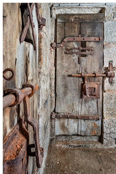
Portes et ferrures. Phot. Jérôme Mongreville IVR43_20233900774NUC4A
