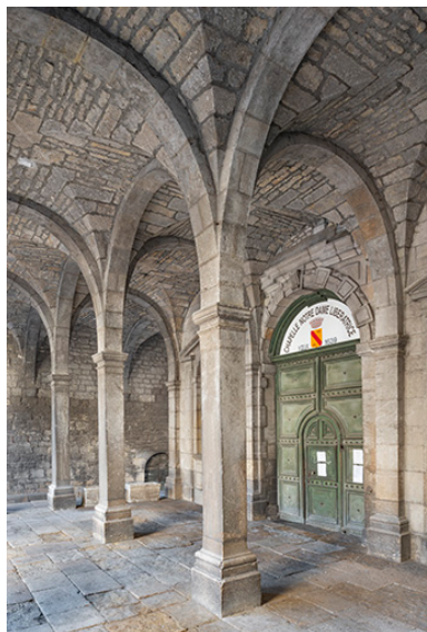
Parvis de la chapelle et travées du voûtement. Phot. Jérôme Mongreville IVR43_20223901275NUC4A
