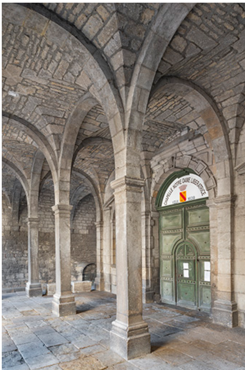
Parvis de la chapelle et travées du voûtement.
