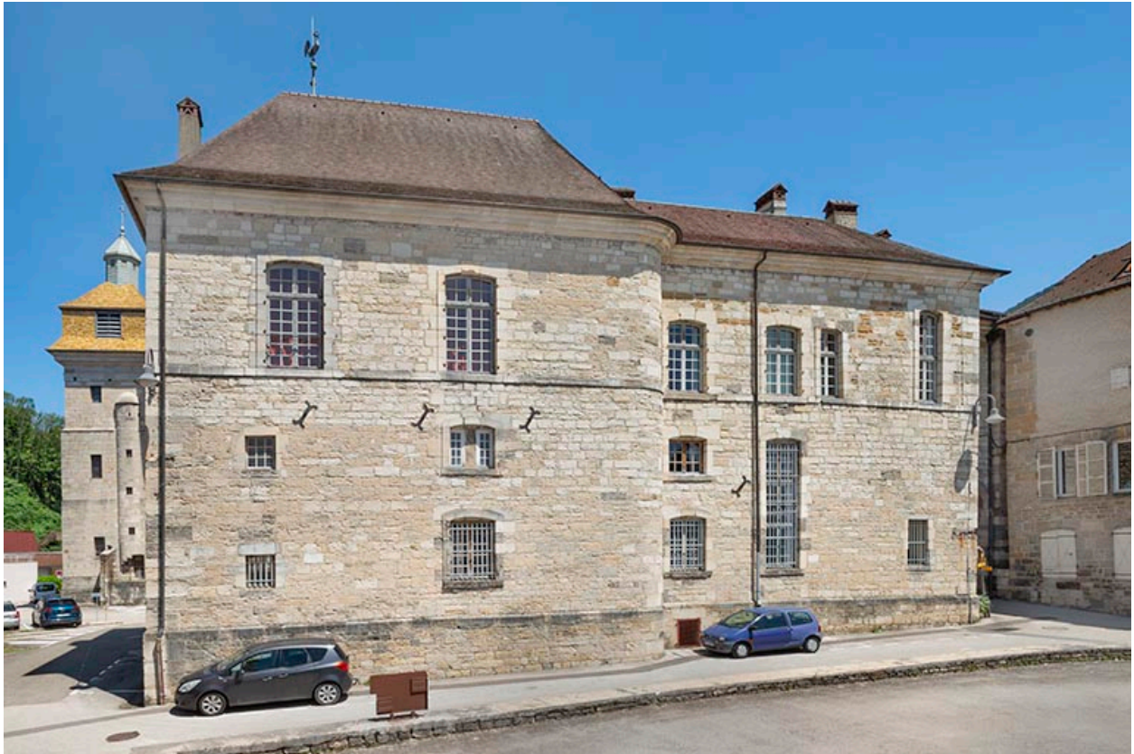
Elévation sud, depuis le sud-ouest.
