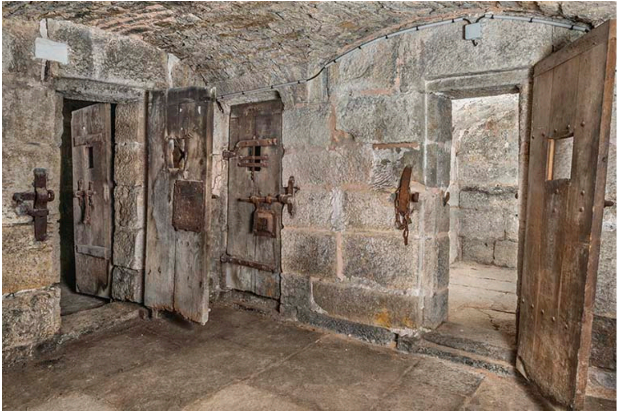
Portes de cellule.
