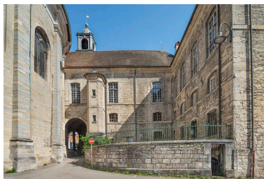
Façade ouest de la partie sud, avec la cour. Phot. Jérôme Mongreville IVR43_20243900879NUC4A
