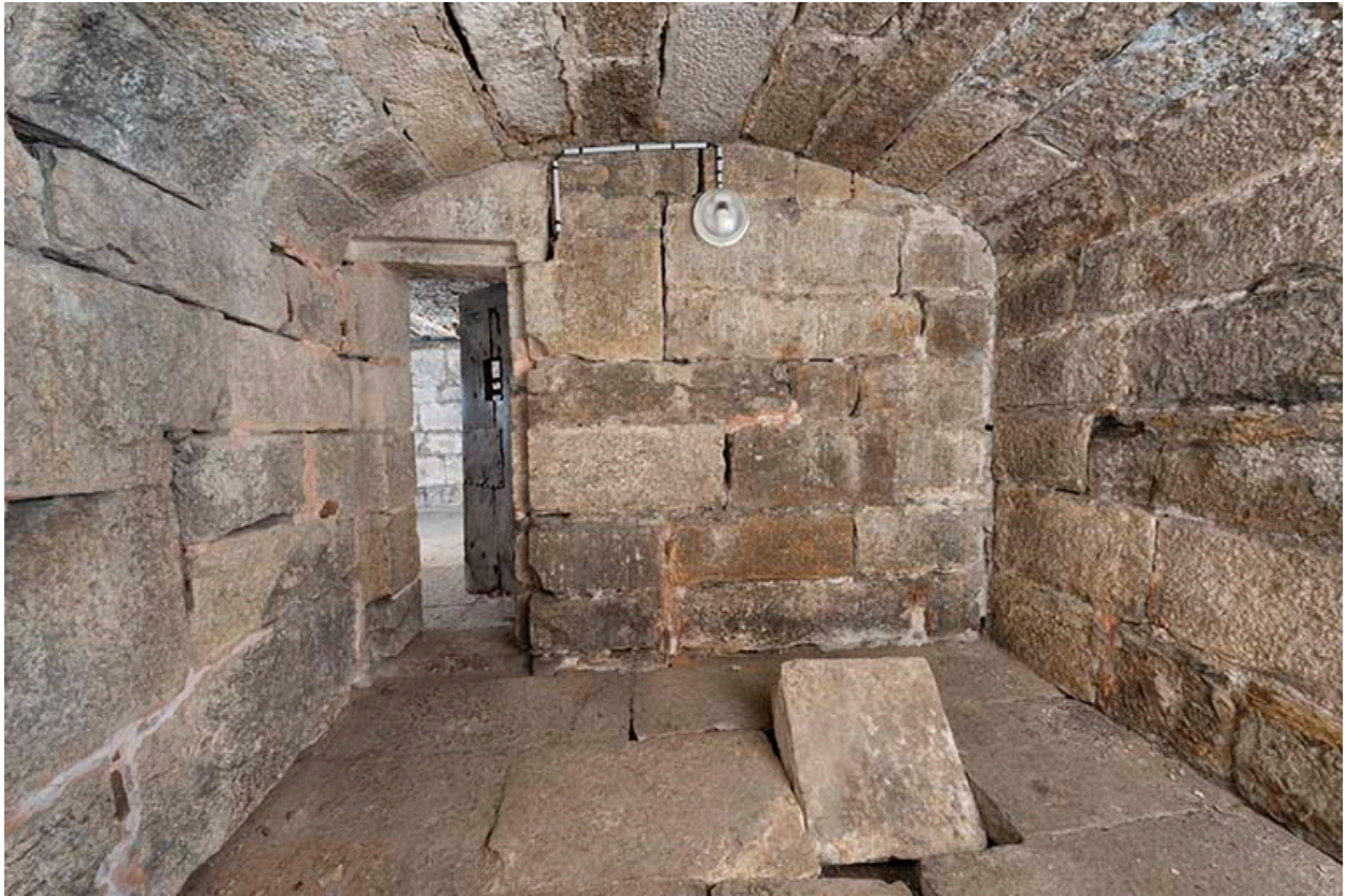
Intérieur d'une cellule.
