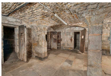
Vue d'ensemble du vestibule ouvrant sur les cellules (portes ouvertes). Phot. Jérôme Mongreville IVR43_20233900765NUC4A
