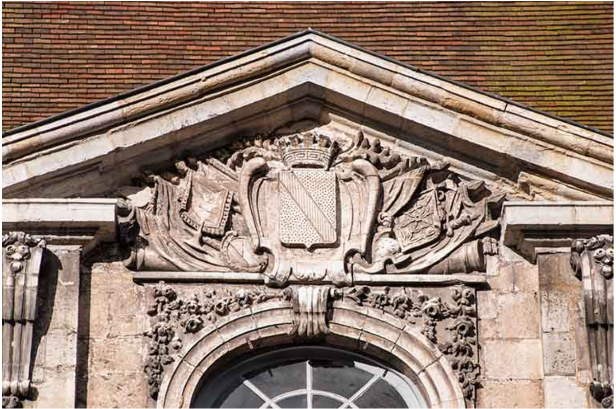
Détail du fronton de la façade est.
