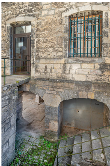
Escalier d'accès aux cellules, depuis la cour ouest. Phot. Jérôme Mongreville IVR43_20233900782NUC4A
