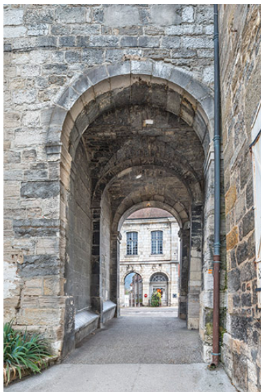
Aile sud. Passage couvert donnant sur la rue de la Tour de Flore. Phot. Jérôme Mongreville IVR43_20243901088NUC4A
