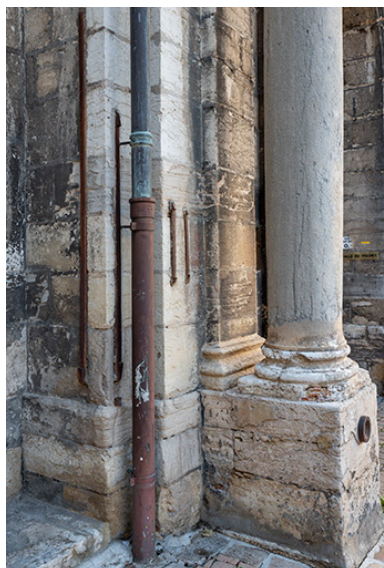
Toises métalliques (piédroit du passage couvert, corps de bâtiment principal). Phot. Jérôme Mongreville IVR43_20223901278NUC4A
