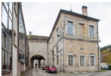
Aile nord vue de trois quarts. Phot. Jérôme Mongreville IVR43_20243901091NUC4A
