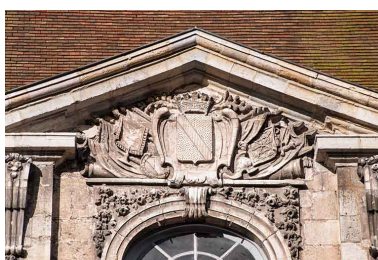
Détail du fronton de la façade est. Phot. Jérôme Mongreville IVR43_20143900035NUC4A
