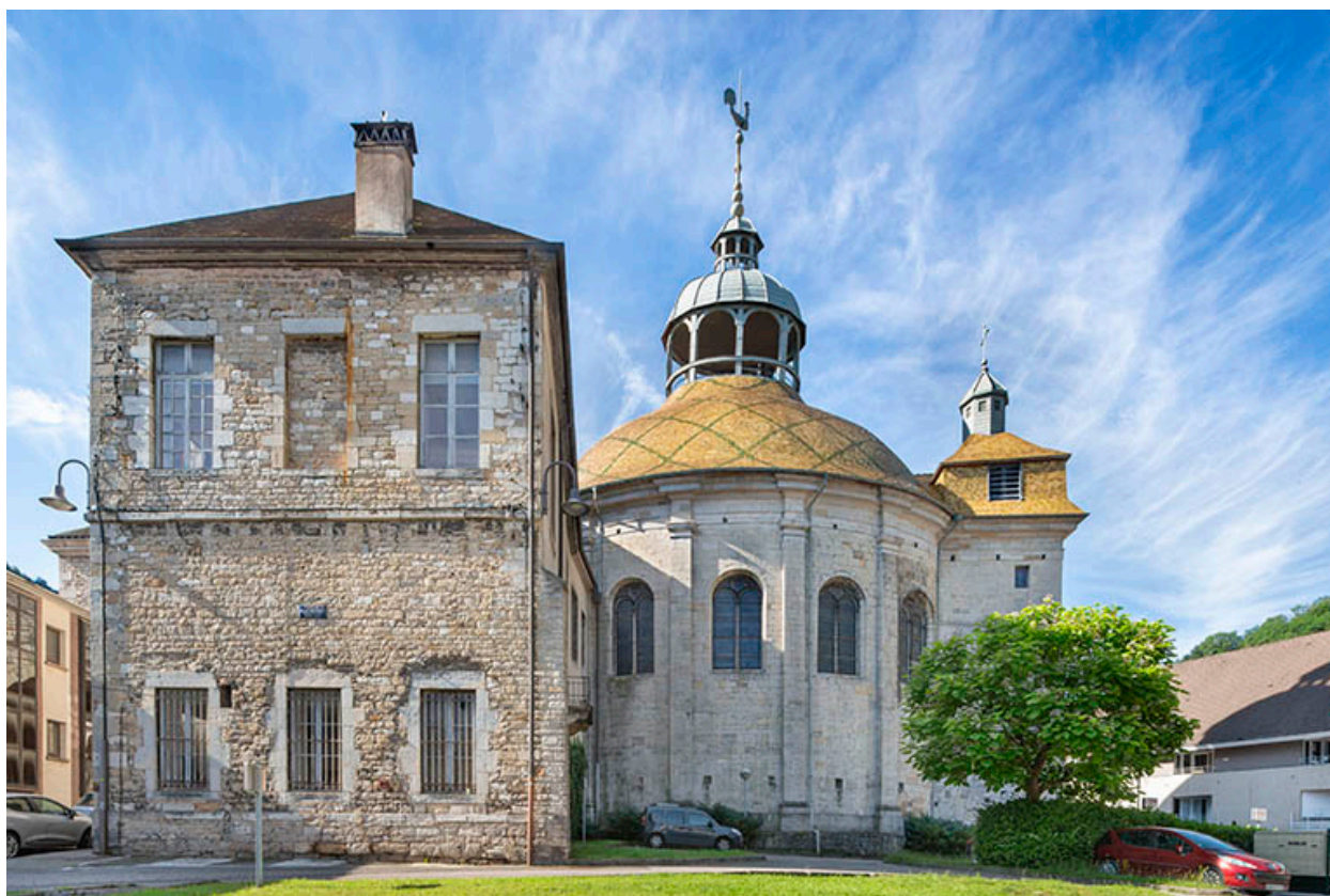
Vue rapprochée, depuis le nord.
