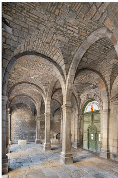
Parvis de la chapelle (et voûtement du rez-de-chaussée). Vue depuis le nord. Phot. Jérôme Mongreville IVR43_20223901274NUC4A
