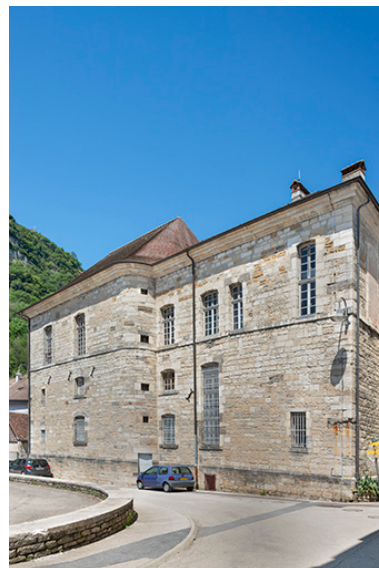
Elévation sud, vue de trois quarts droite. Phot. Jérôme Mongreville IVR43_20243900810NUC4A
