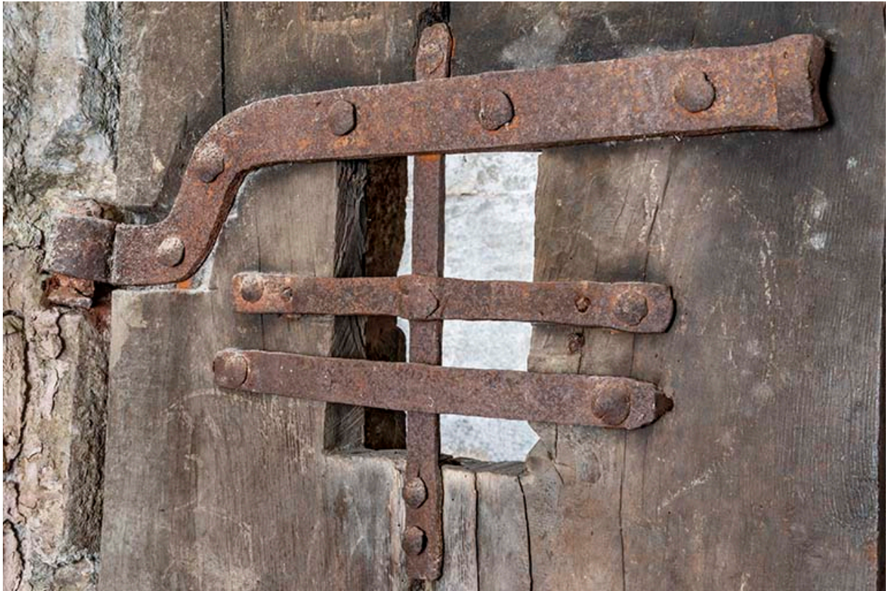
Porte de cellule. Détail d'une fenêtre ferrée.
