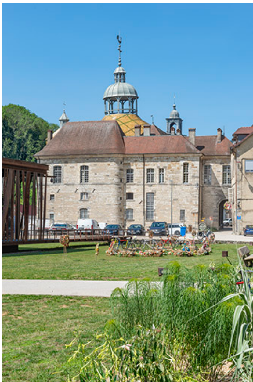
Façade sud, depuis l'esplanade des salines.
