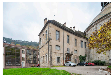
Aile nord, vue de trois quarts arrière. Phot. Jérôme Mongreville IVR43_20243901092NUC4A
