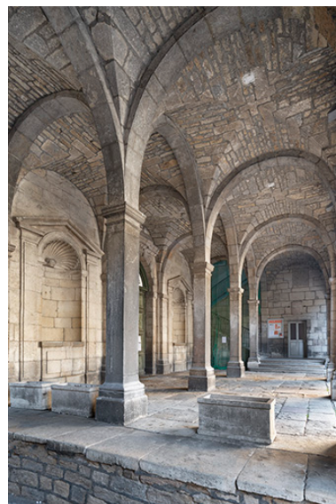
Parvis de la chapelle (et voûtement du rez-de-chaussée). Vue de trois quarts. Phot. Jérôme Mongreville IVR43_20223901273NUC4A
