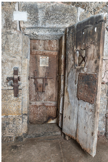
Portes doubles d'une cellule. Phot. Jérôme Mongreville IVR43_20233900771NUC4A
