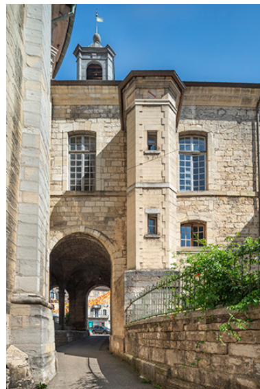
Elévation de la partie sud. Tour d'escalier hors-oeuvre. Phot. Jérôme Mongreville IVR43_20243900880NUC4A
