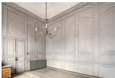
Aile nord. Pièce au premier étage, vue de trois quarts. Phot. Jérôme Mongreville IVR43_20233900742NUC4A
