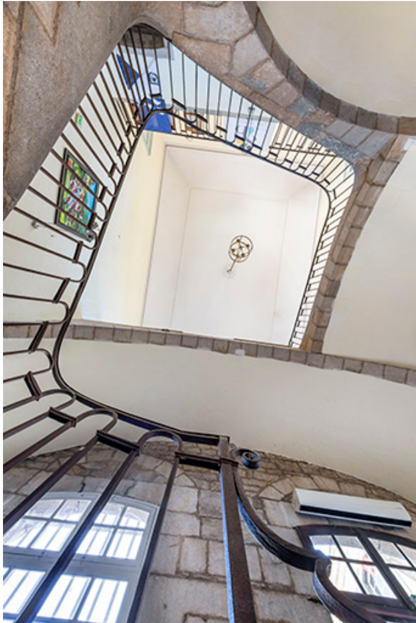
Ancien tribunal. Vue en contre-plongée de la cage d'escalier.
