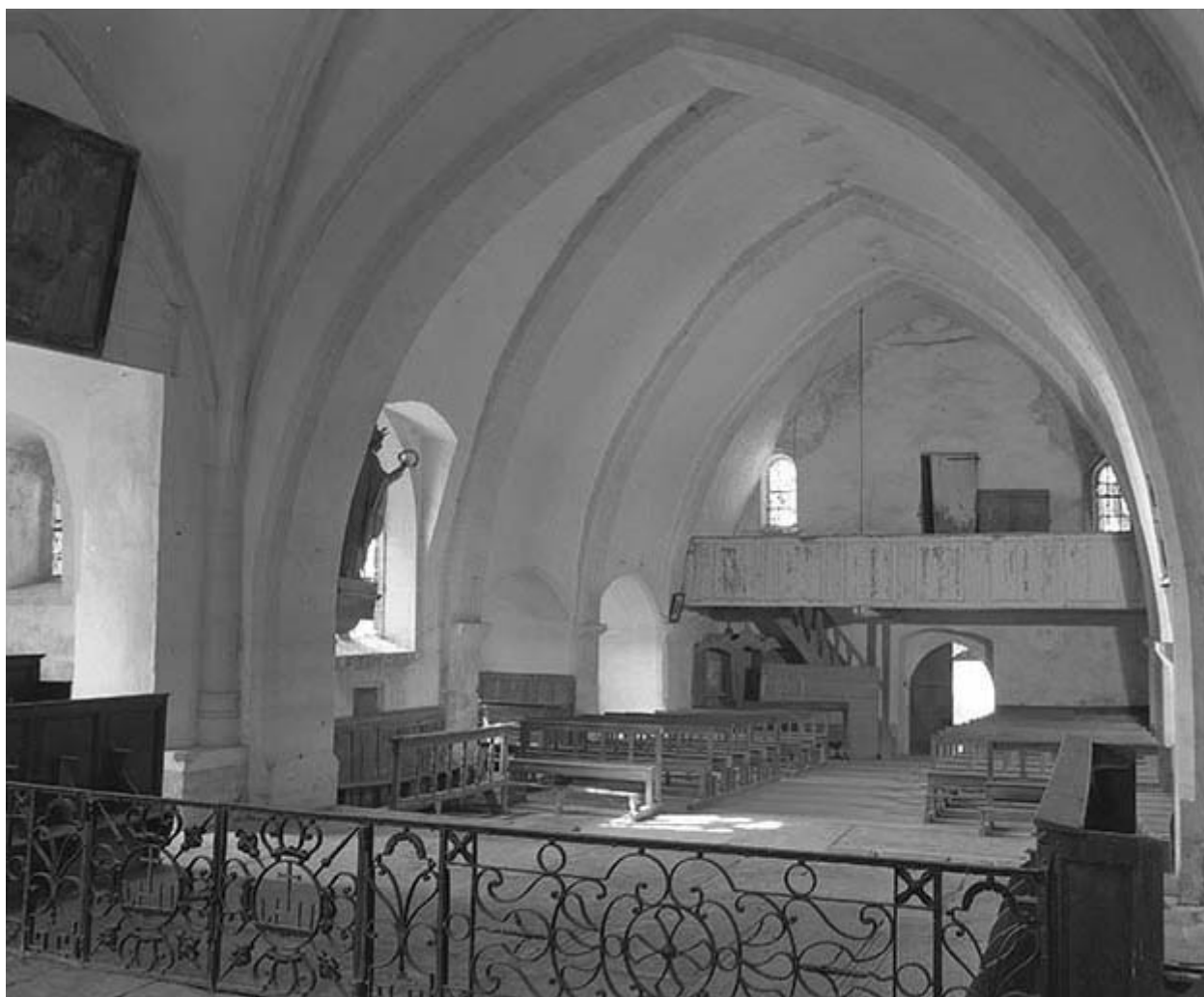
Intérieur : élévation droite vue depuis le chœur.
