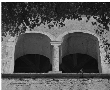
Extérieur : détail, baies du clocher, face antérieure. Phot. Yves Sancey IVR43_19783900019X
