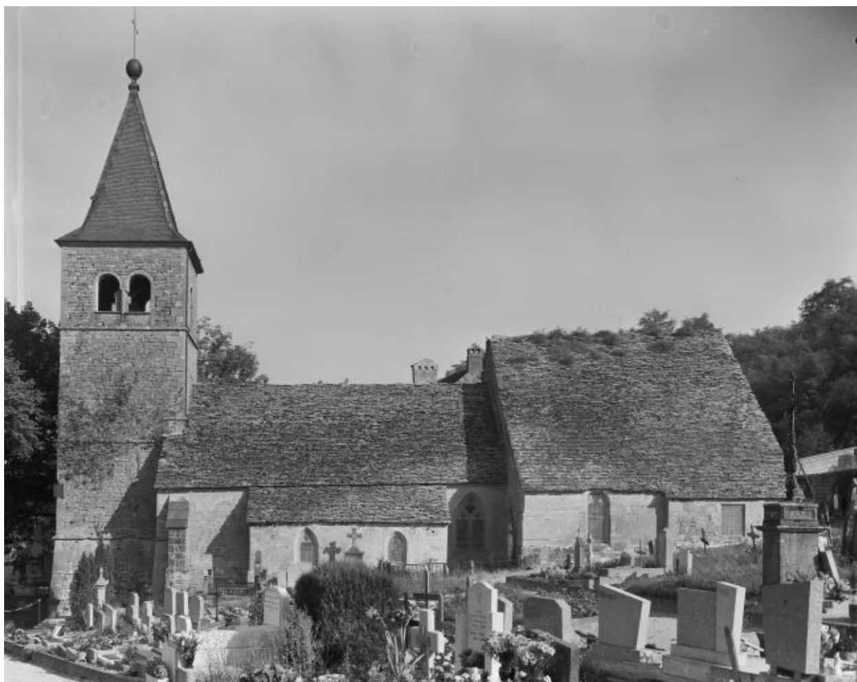
Façade latérale droite.
