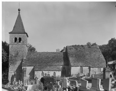
Façade latérale droite. Phot. Yves Sancey IVR43_19783900015V
