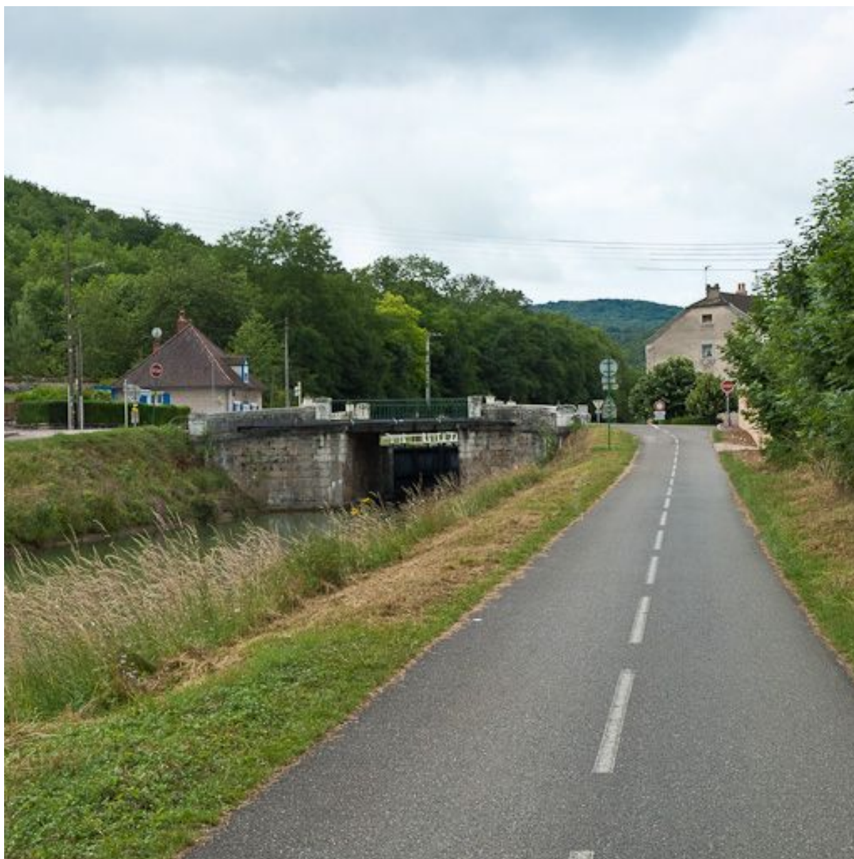
Vue du pont sur écluse depuis l'aval.
