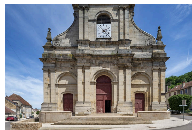
Premier niveau de la façade antérieure. Phot. Jérôme Mongreville IVR43_20217000370NUC4A
