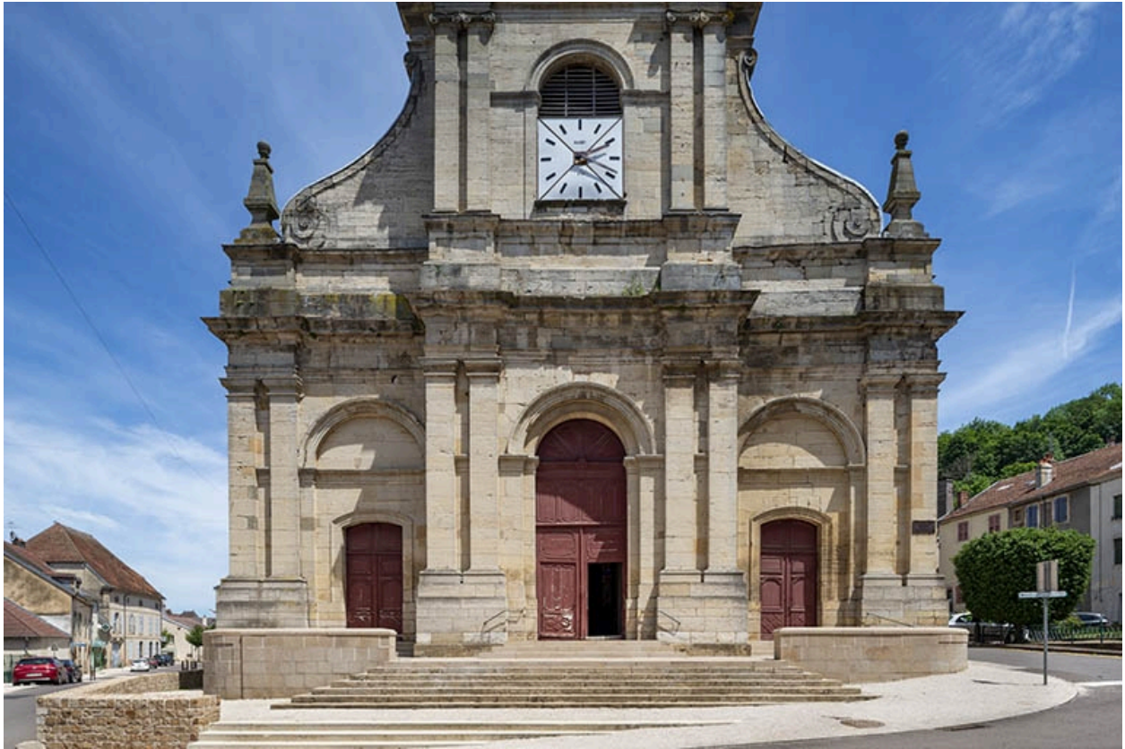
Premier niveau de la façade antérieure.
