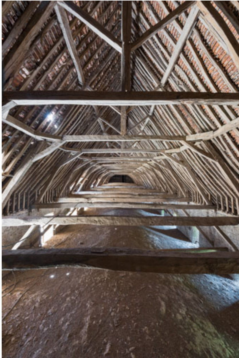
Ecurie, étage de comble : extrados de voûte et charpente.
