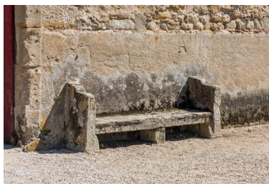
Façade antérieure : banc. Phot. Pierre-Marie Barbe-Richaud IVR26_20227100089NUC4A
