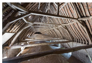
Ecurie, étage de comble : charpente, vue de trois quarts. Phot. Pierre-Marie Barbe-Richaud IVR26_20227100104NUC4A
