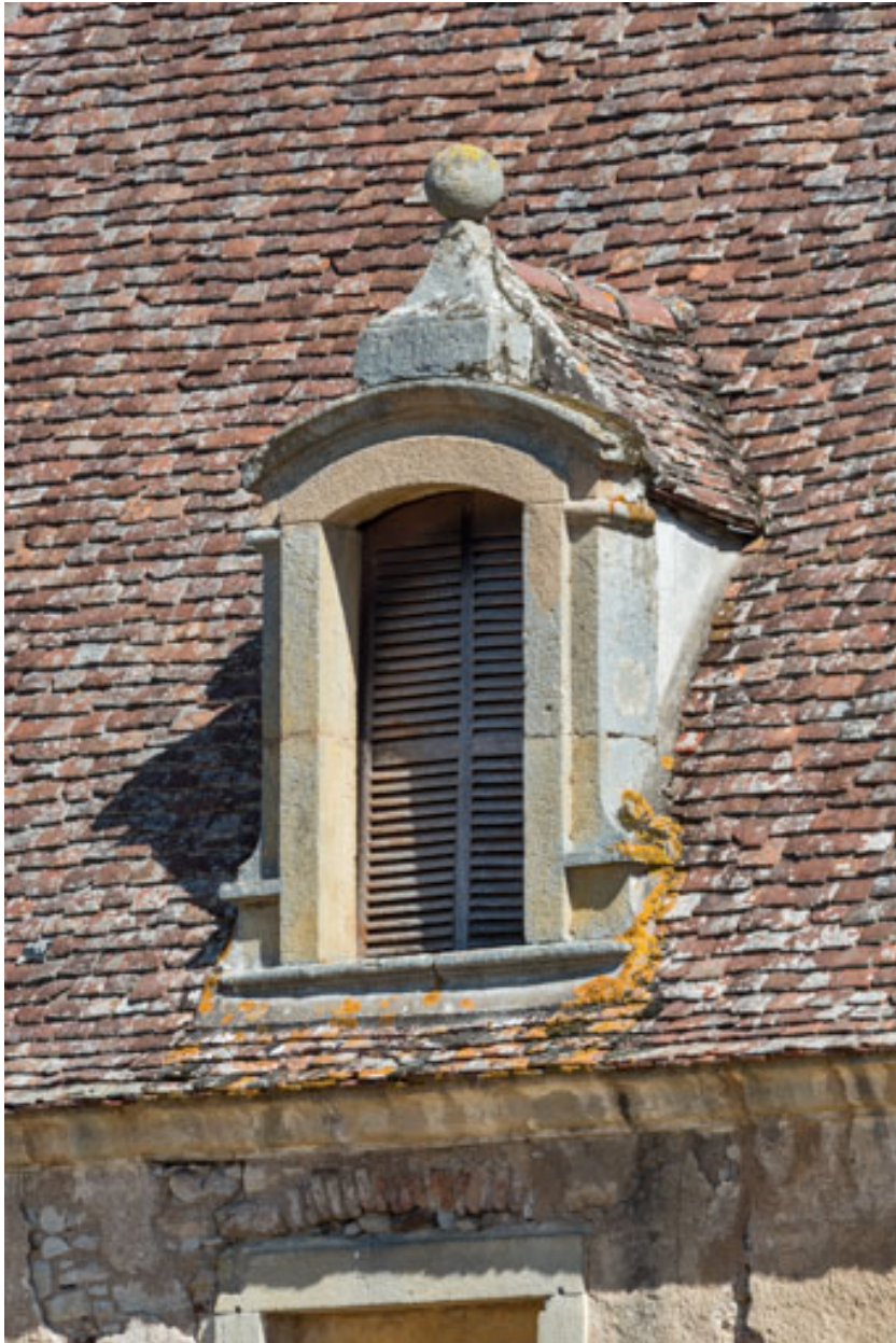
Façade antérieure : lucarne avec motif d'amortissement sphérique.
