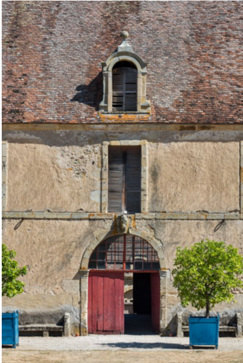
Façade antérieure : travée centrale.
