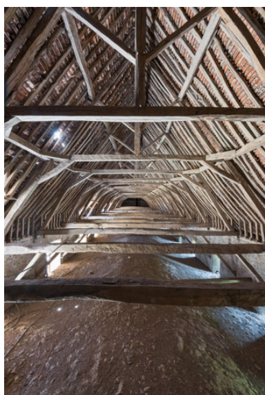
Ecurie, étage de comble : extrados de voûte et charpente. Phot. Pierre-Marie Barbe-Richaud IVR26_20227100106NUC4A
