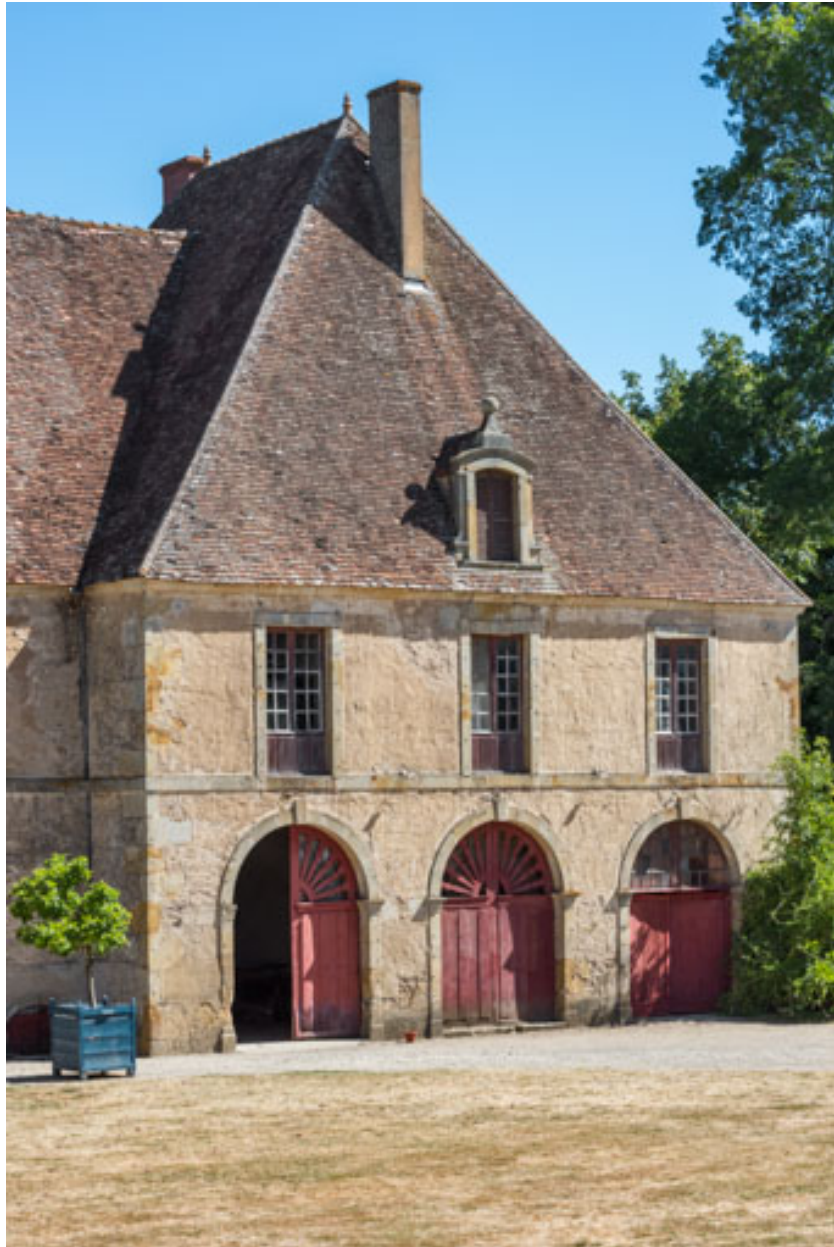
Façade antérieure : pavillon oriental (remises).
