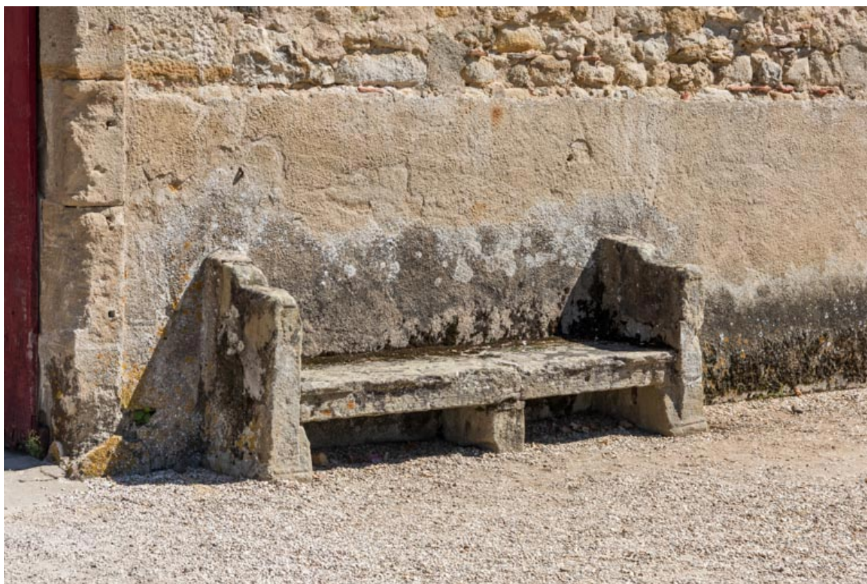
Façade antérieure : banc.
