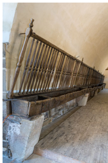
Ecurie, partie orientale : mangeoire en bois, vue en enfilade. Phot. Pierre-Marie Barbe-Richaud IVR26_20227100101NUC4A
