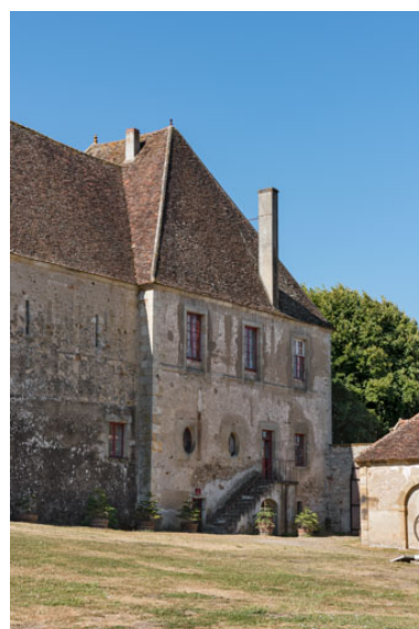
Façade postérieure : pavillon occidental. Phot. Pierre-Marie Barbe-Richaud IVR26_20227100078NUC4A
