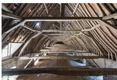
Ecurie, étage de comble : charpente. Phot. Pierre-Marie Barbe-Richaud IVR26_20227100105NUC4A
