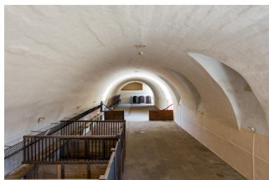
Ecurie : la voûte depuis la tribune occidentale. Phot. Pierre-Marie Barbe-Richaud IVR26_20227100097NUC4A
