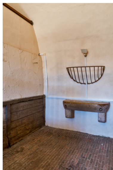
Ecurie, partie occidentale : intérieur d'une stalle. Phot. Pierre-Marie Barbe-Richaud IVR26_20227100094NUC4A
