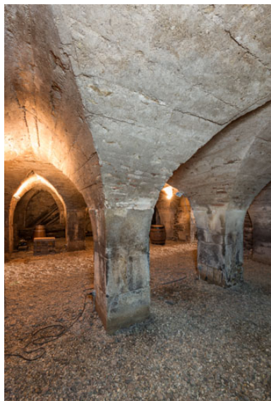
Pavillon occidental : cave à l'étage de soubassement. Phot. Pierre-Marie Barbe-Richaud IVR26_20227100102NUC4A
