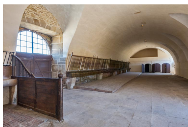
Ecurie : partie orientale. Phot. Pierre-Marie Barbe-Richaud IVR26_20227100098NUC4A
