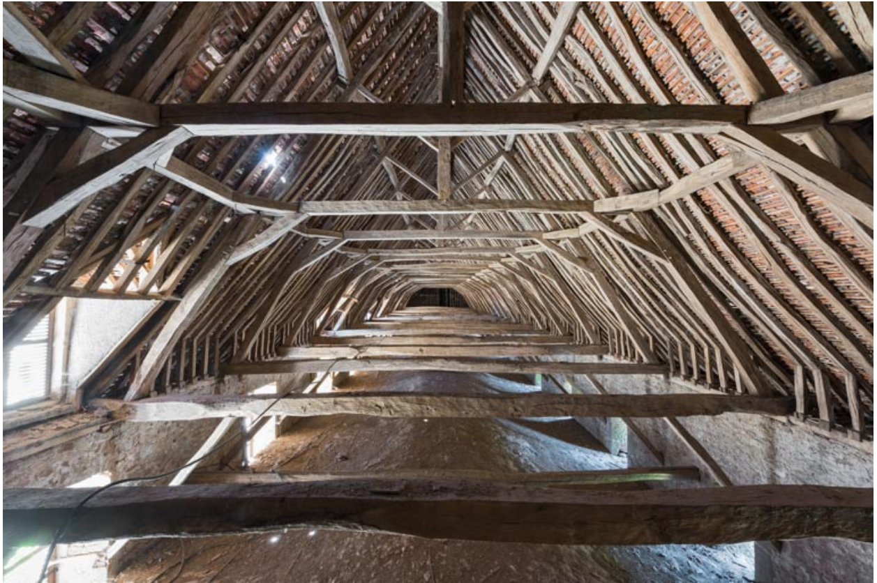
Ecurie, étage de comble : charpente.
