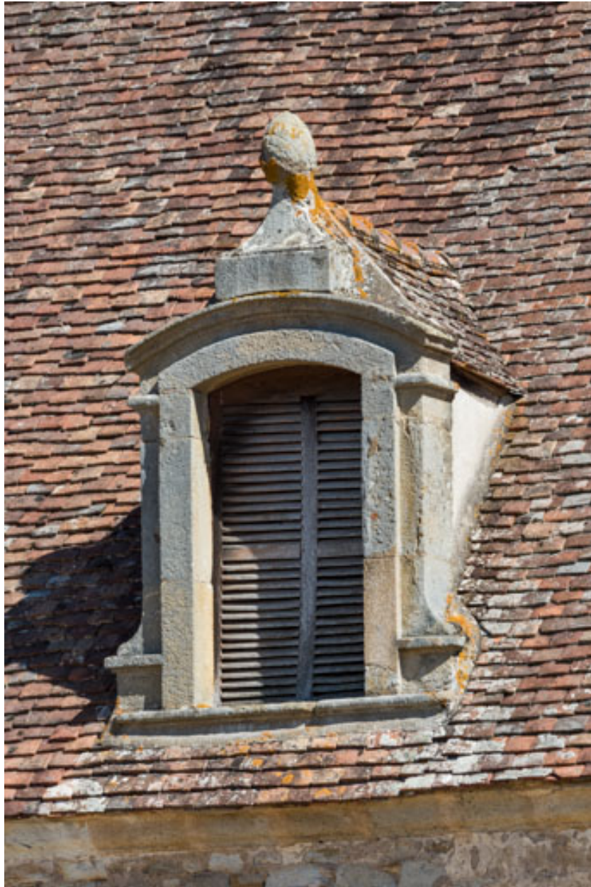
Façade antérieure : lucarne avec motif d'amortissement en pomme de pin.
