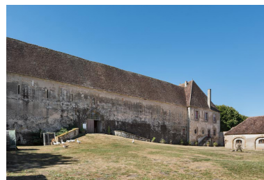
Façade postérieure, de trois quarts gauche. Phot. Pierre-Marie Barbe-Richaud IVR26_20227100077NUC4A
