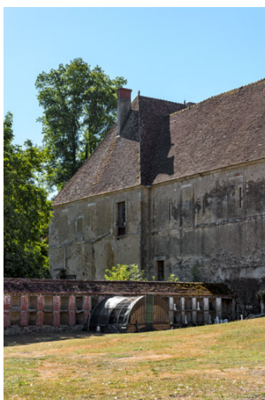
Façade postérieure : pavillon oriental. Phot. Pierre-Marie Barbe-Richaud IVR26_20227100079NUC4A
