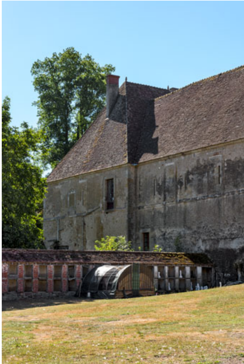
Façade postérieure : pavillon oriental.
