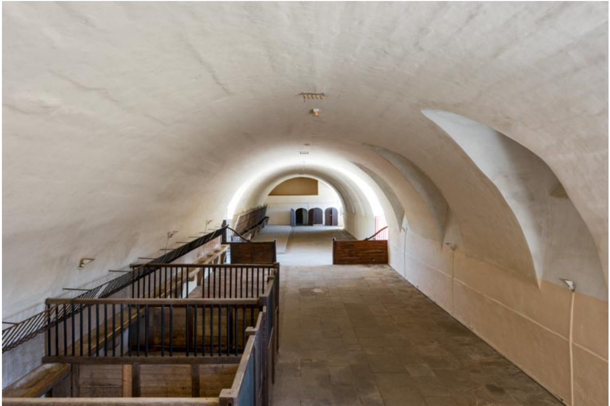
Ecurie : la voûte depuis la tribune occidentale.
