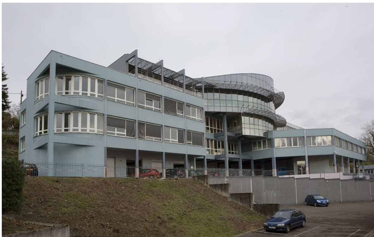
Vue d'ensemble bâtiment D depuis parking.
