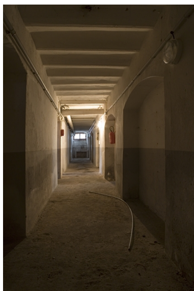
Bâtiment A : sous-sol. Vue du couloir. Phot. Yves Sancey IVR43_20072500946NUCA
