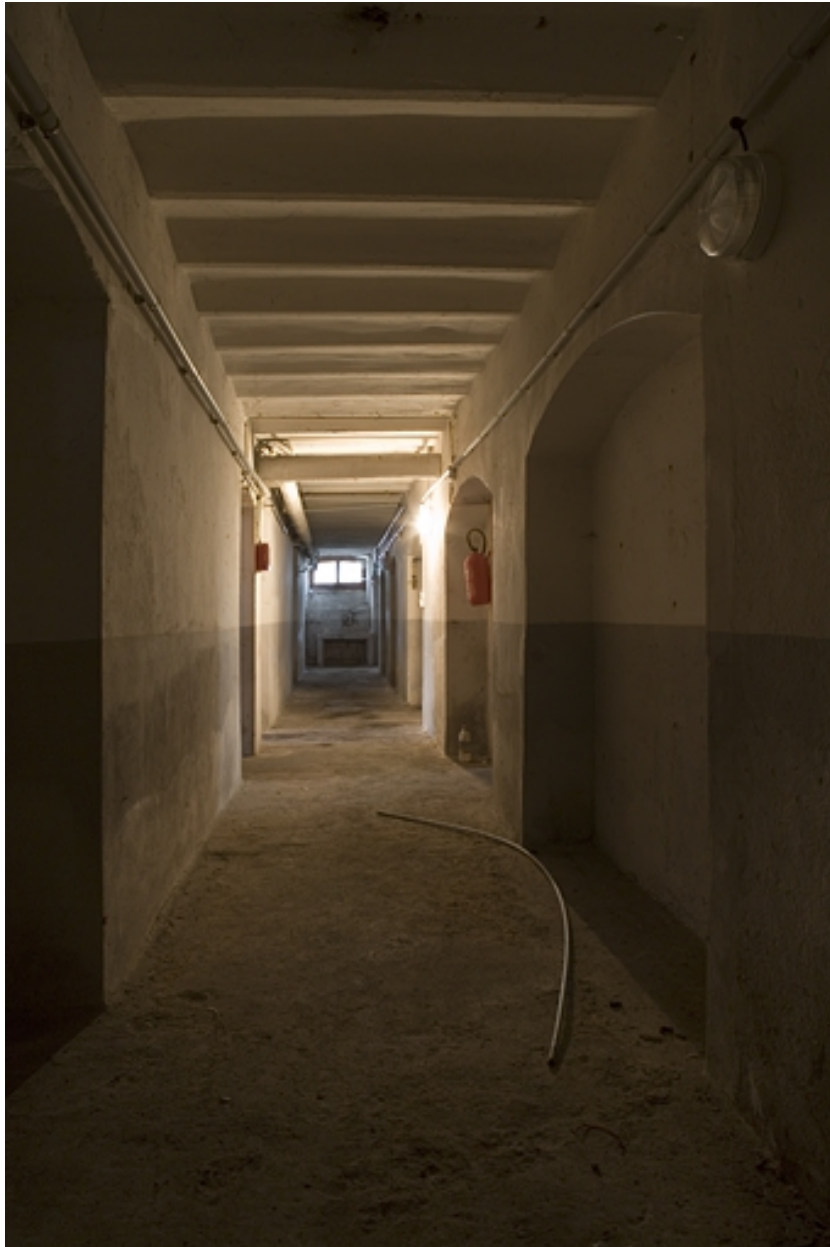
Bâtiment A : sous-sol. Vue du couloir.
