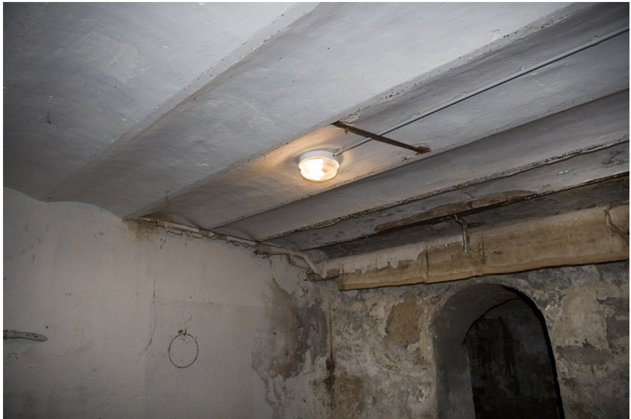
Bâtiment A : sous-sol. Détail voûtains.
