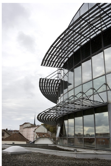
Tour bâtiment D. Détail brise-soleil métalliques. Phot. Yves Sancey IVR43_20072500971NUCA
