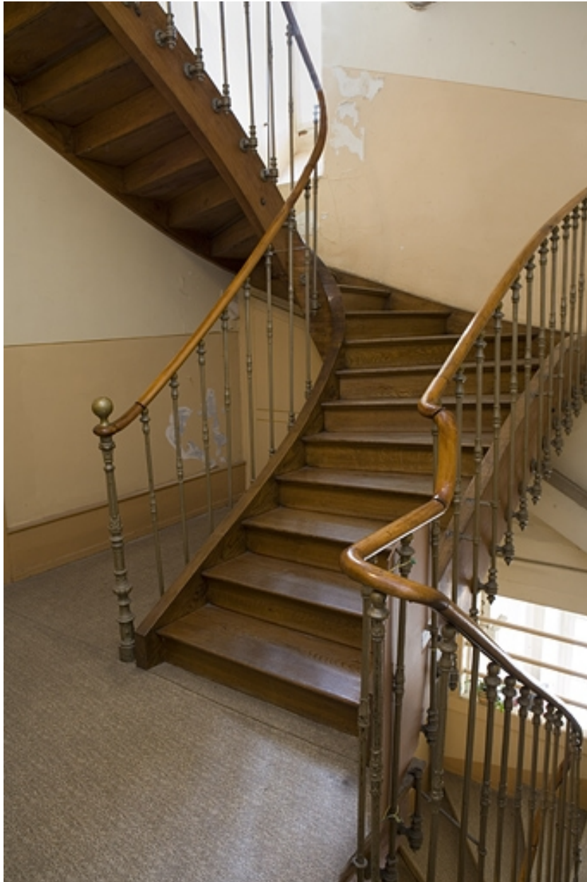
Bâtiment A. Vue de l'escalier.
