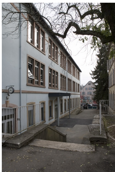
Bâtiment B. Vue face latérale droite. Phot. Yves Sancey IVR43_20072500973NUCA
