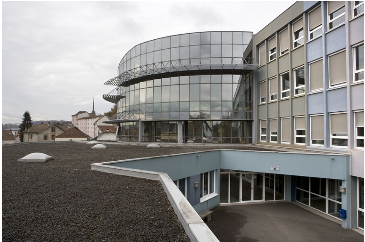
Vue tour bâtiment D depuis le toit.
