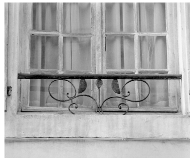
Façade sur rue. Détail d'un balconnet. Phot. Jérôme Mongreville IVR43_19882500104X
