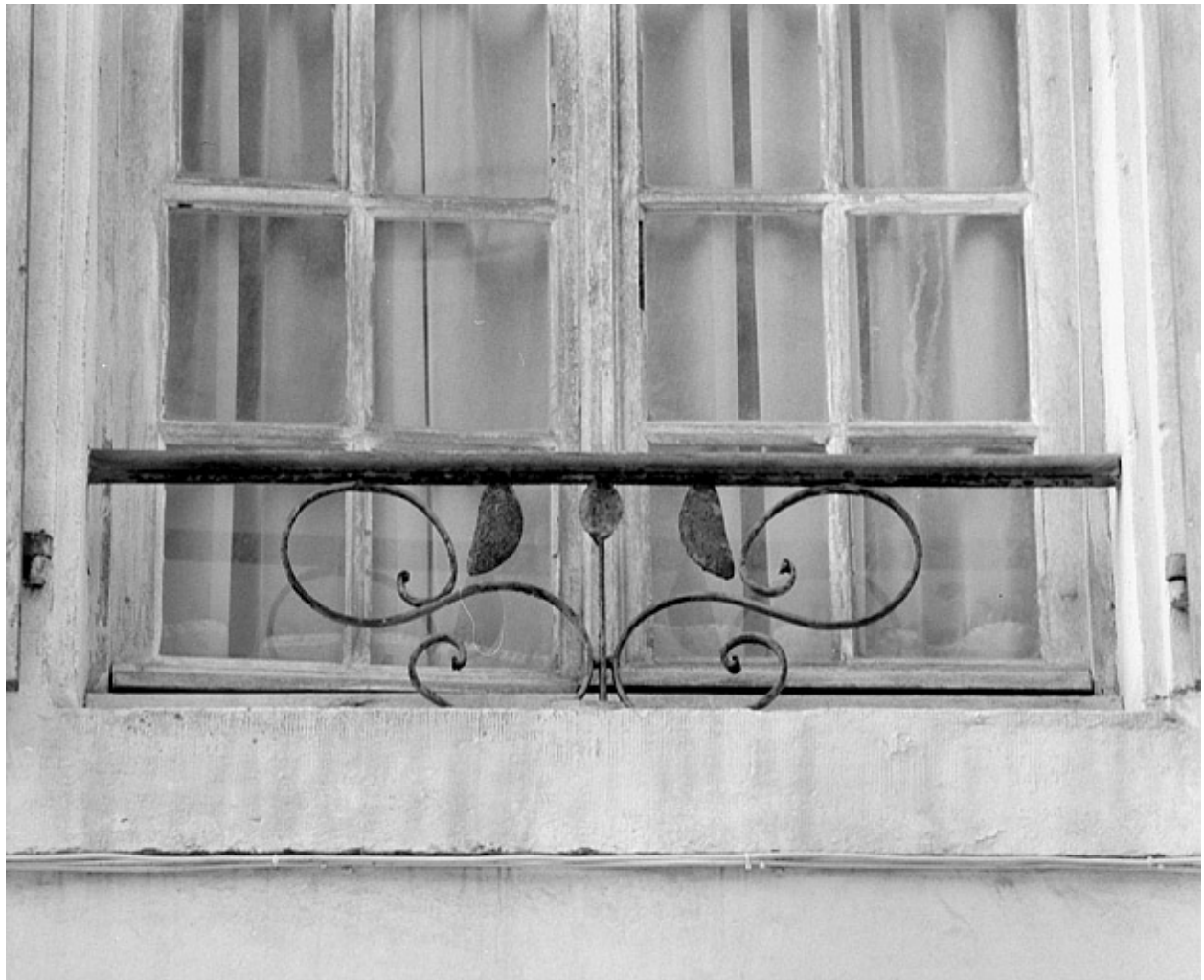
Façade sur rue. Détail d'un balconnet.
