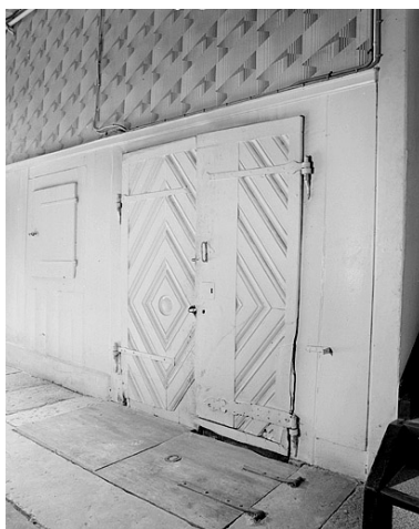
Porte de la cave dans l'allée. Phot. Jérôme Mongreville IVR43_19872500761X
