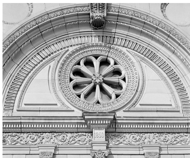
Façade principale, tympan du portail. Phot. Jérôme Mongreville IVR43_19882500114X
