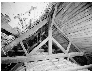
Charpente de la nef et extrados de la fausse-voûte. Phot. Jérôme Mongreville IVR43_19882500018V
