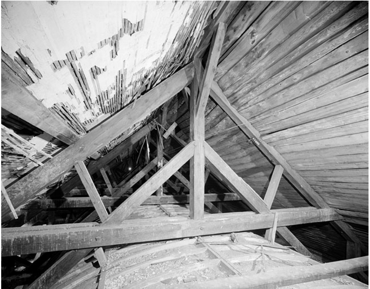
Charpente de la nef et extrados de la fausse-voûte.
