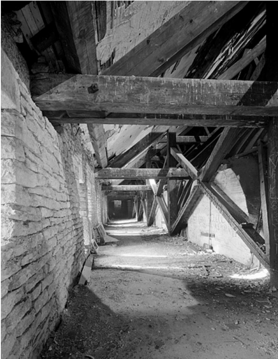
Charpente au-dessus de la tribune droite.
