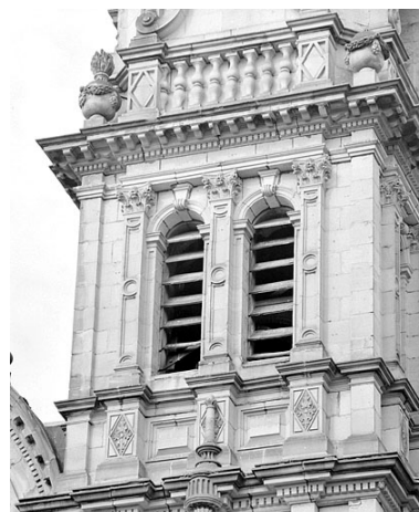
Troisième niveau de la tour nord. Phot. Jérôme Mongreville IVR43_19882500075X
