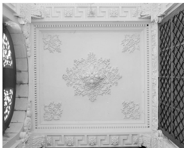
Vestibule, détail du plafond. Phot. Jérôme Mongreville IVR43_19872500871X
