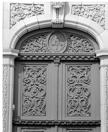
Façade principale, détail de la menuiserie de la porte de droite. Phot. Jérôme Mongreville IVR43_19882500112X
