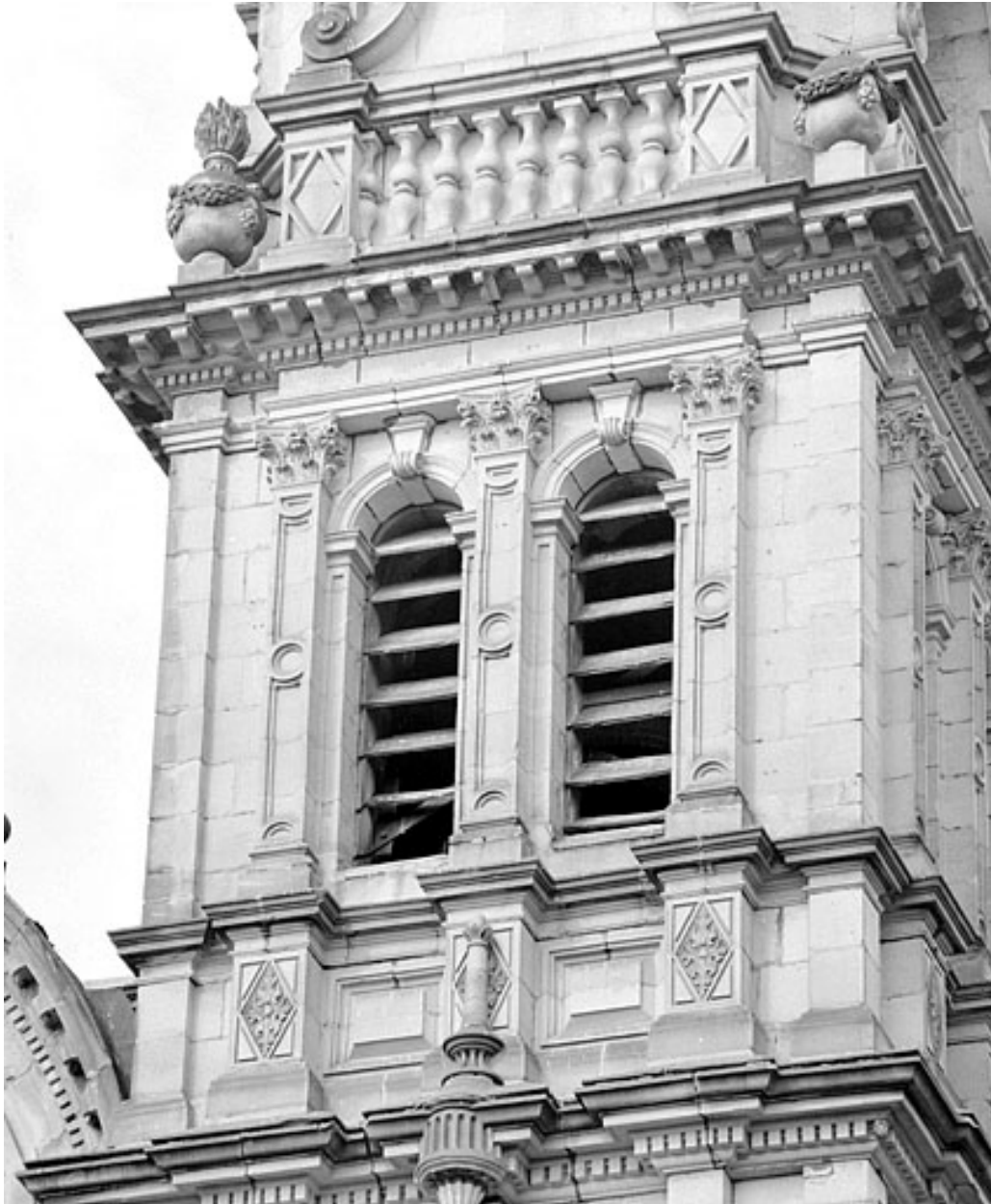
Troisième niveau de la tour nord.
