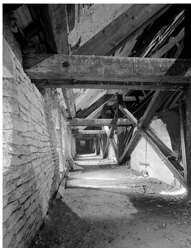
Charpente au-dessus de la tribune droite. Phot. Jérôme Mongreville IVR43_19882500017V
