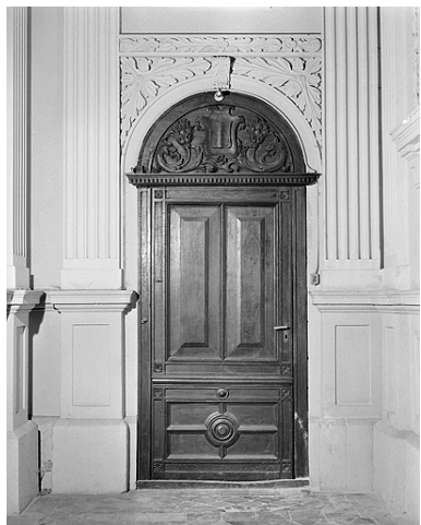
Vestibule, porte d'accès à la tour nord. Phot. Jérôme Mongreville IVR43_19872501051X
