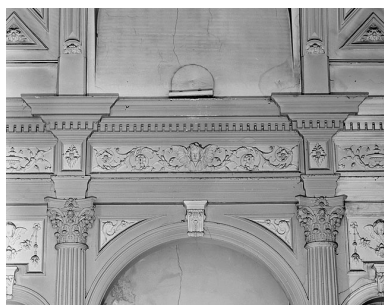
Détail de la partie supérieure d'une travée large de la tribune. Phot. Jérôme Mongreville IVR43_19872500702X
