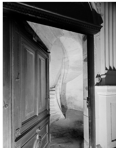
Escalier de la tour nord. Phot. Jérôme Mongreville IVR43_19882500019V
