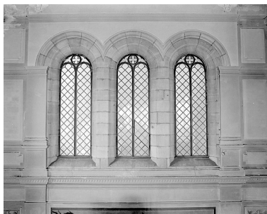
Fenêtres du croisillon droit du transept. Phot. Jérôme Mongreville IVR43_19872501053X
