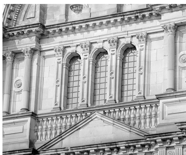
Façade principale, deuxième niveau. Phot. Jérôme Mongreville IVR43_19882500073X
