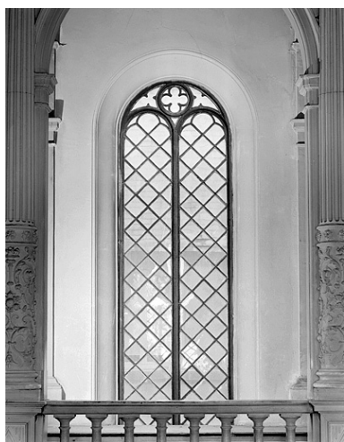
Fenêtre de la nef. Phot. Jérôme Mongreville IVR43_19872501052X
