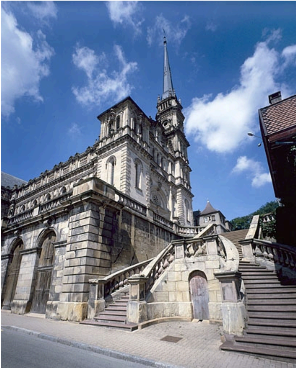
Escalier de la terrasse et façade principale.
