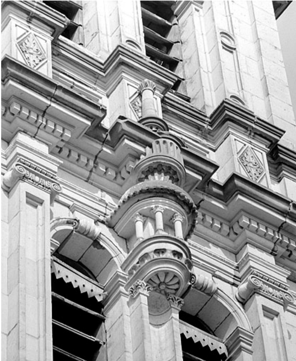
Détail du deuxième niveau de la tour nord.
