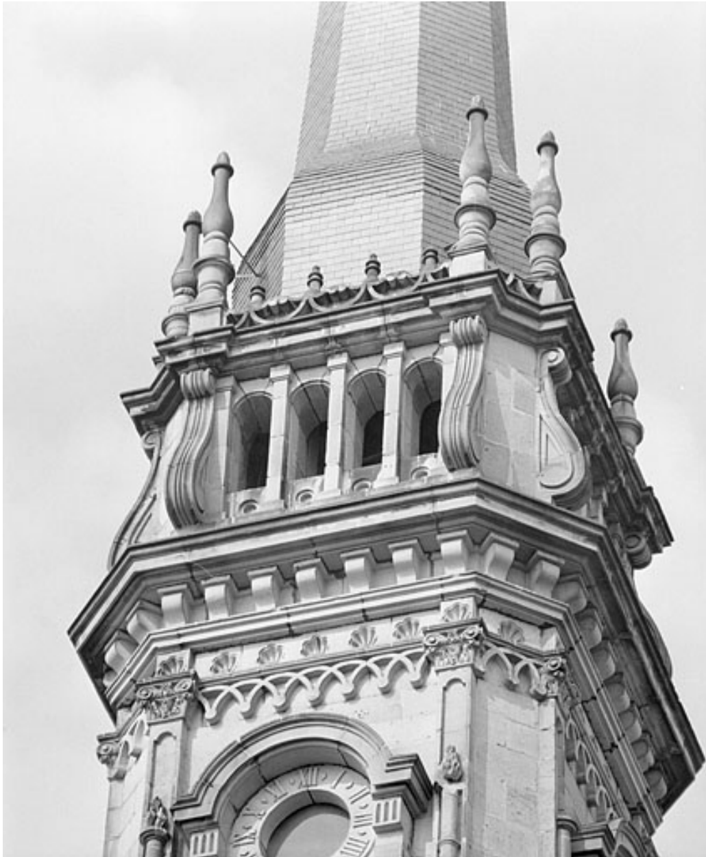
Naissance de la flèche de la tour nord.
