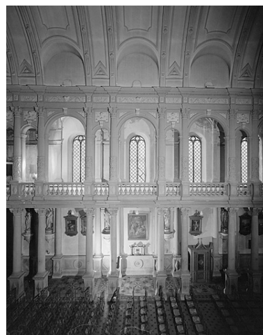
Élévation intérieure droite de la nef. Phot. Jérôme Mongreville IVR43_19882500035V
