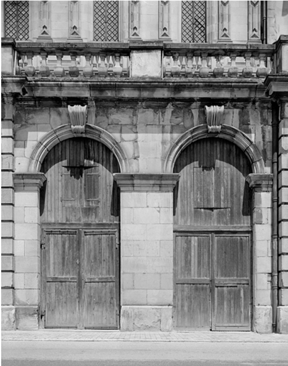
Baies des boutiques.
