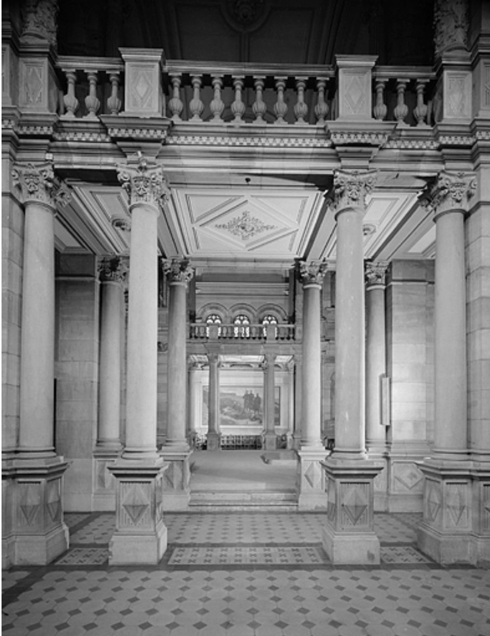
Ensemble du transept.
