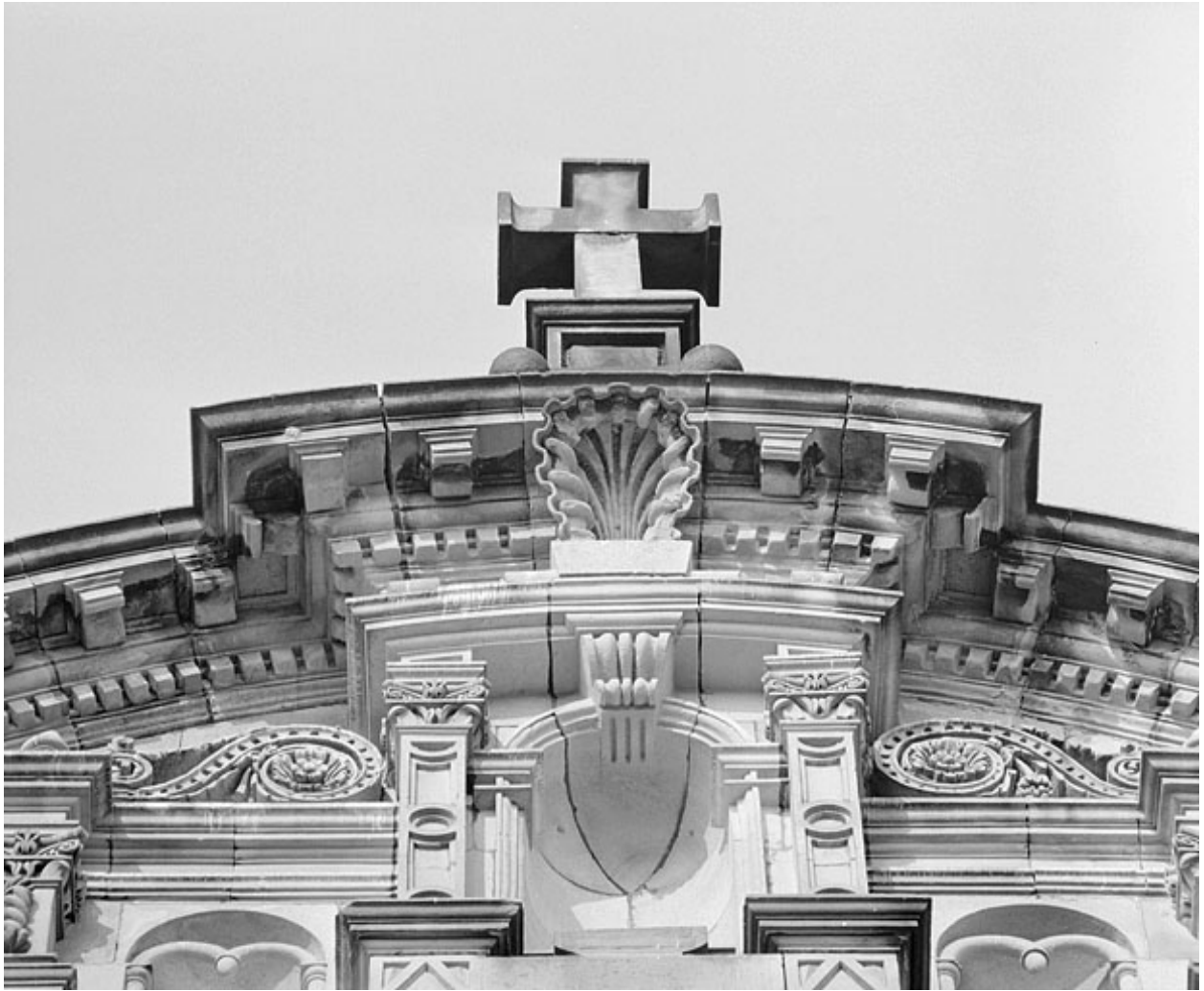
Façade principale, fronton vu d'en dessous.
