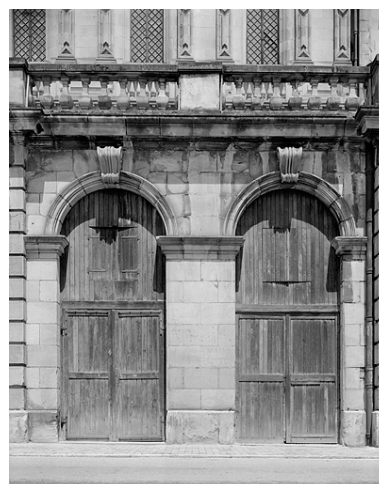
Baies des boutiques. Phot. Jérôme Mongreville IVR43_19882500122V
