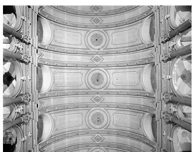
Fausse-voûte de la nef. Phot. Jérôme Mongreville IVR43_19872501194X
