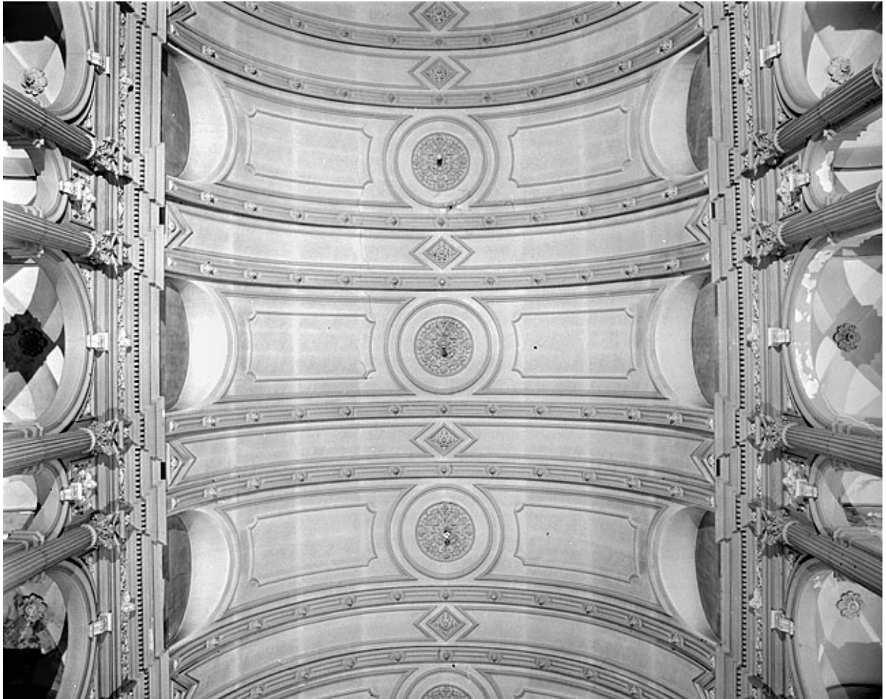
Fausse-voûte de la nef.
