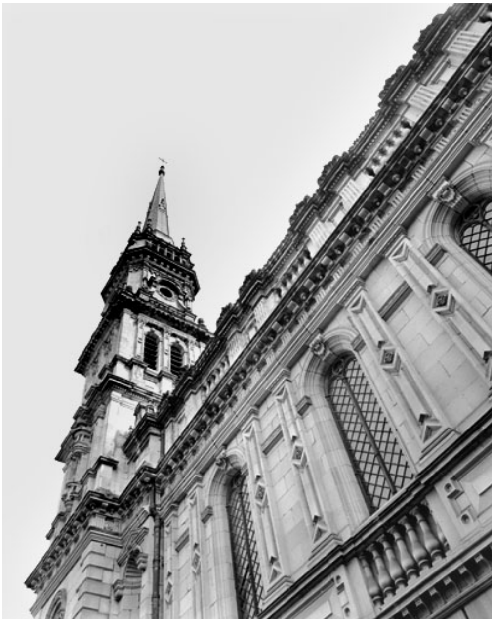
Elévation du deuxième niveau de la nef, côté nord.
