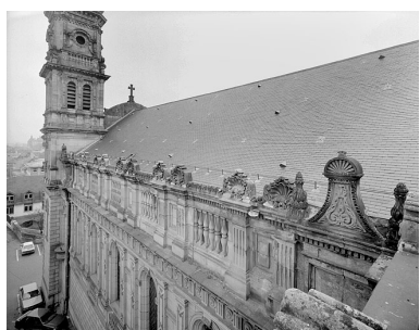
Couronnement de la nef, côté nord. Phot. Jérôme Mongreville IVR43_19882500015V
