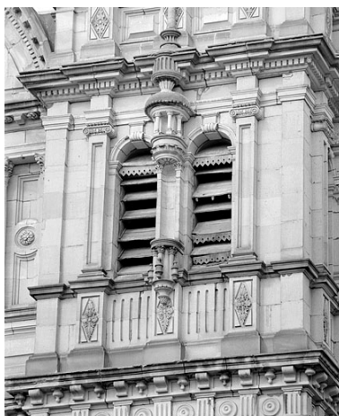
Deuxième niveau de la tour nord. Phot. Jérôme Mongreville IVR43_19882500074X
