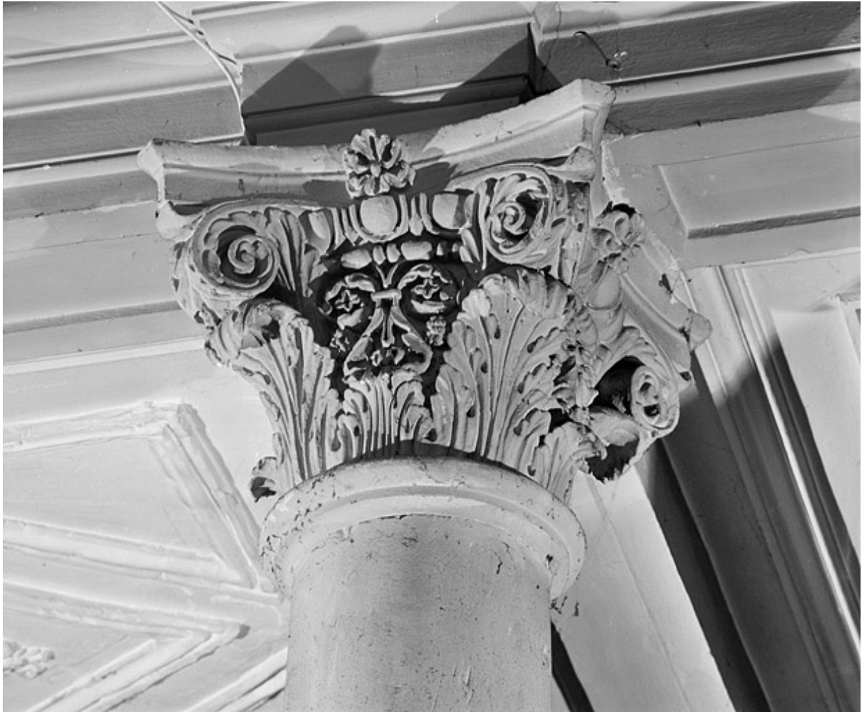
Chapiteau d'une colonne d'un bas-côté de la nef.
