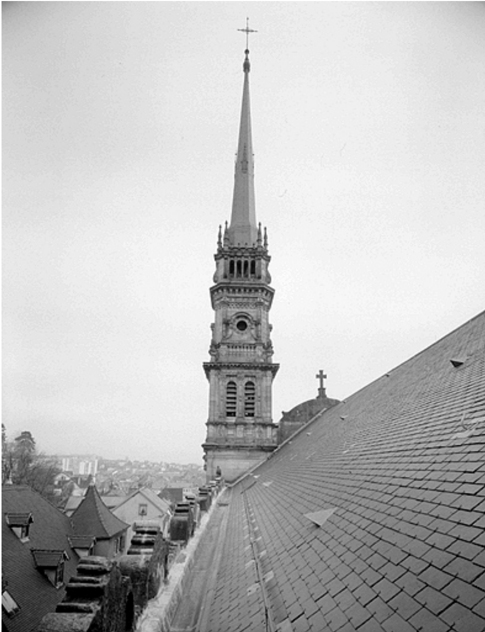
Vue d'ensemble des derniers niveaux de la tour nord et de sa flèche.
