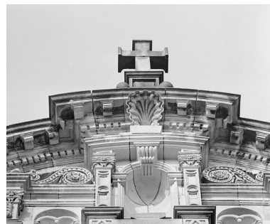
Façade principale, fronton vu d'en dessous. Phot. Jérôme Mongreville IVR43_19882500071X
