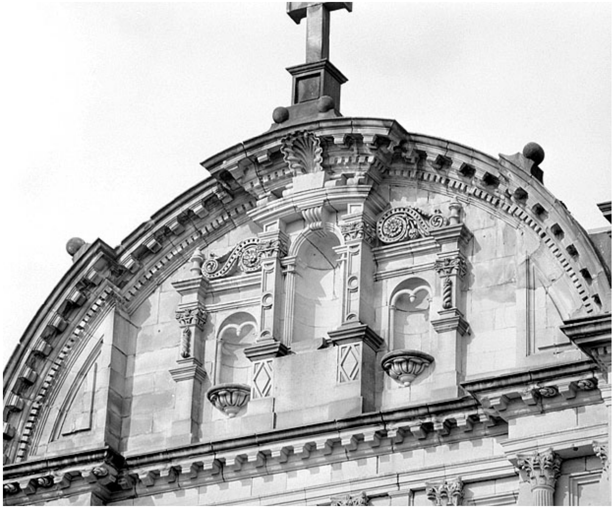
Façade principale, fronton.
