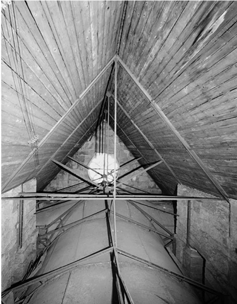
Charpente du transept.
