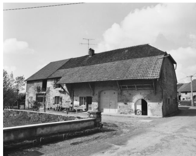
Façade antérieure. Phot. Dominique Dominguez IVR43_19783900162X
