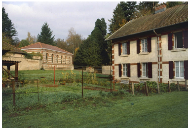
Dépendances au sud. Phot. Yves Sancey IVR43_20009000789ZA
