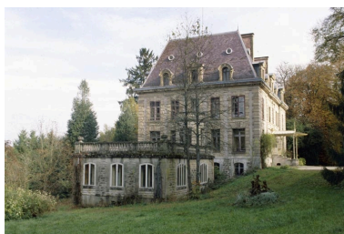
Vue depuis l'ouest.
