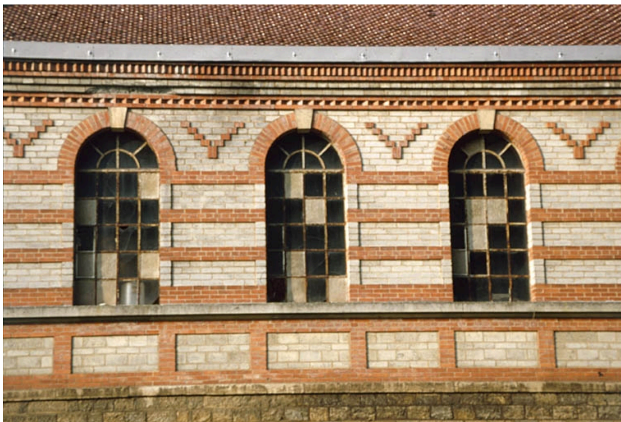
Détail de la façade est de l'orangerie.
