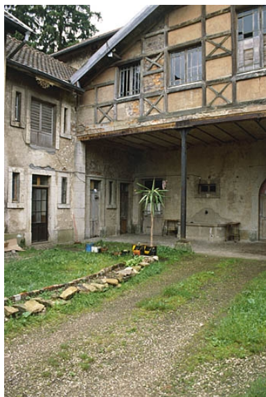
Logement et pignon de l'écurie. Phot. Yves Sancey IVR43_20009000485ZA
