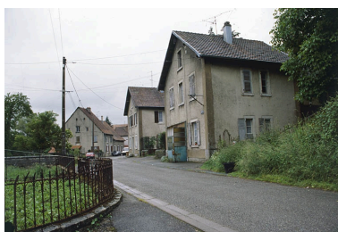
L'écurie depuis l'ouest. Phot. Yves Sancey IVR43_20009000479ZA
