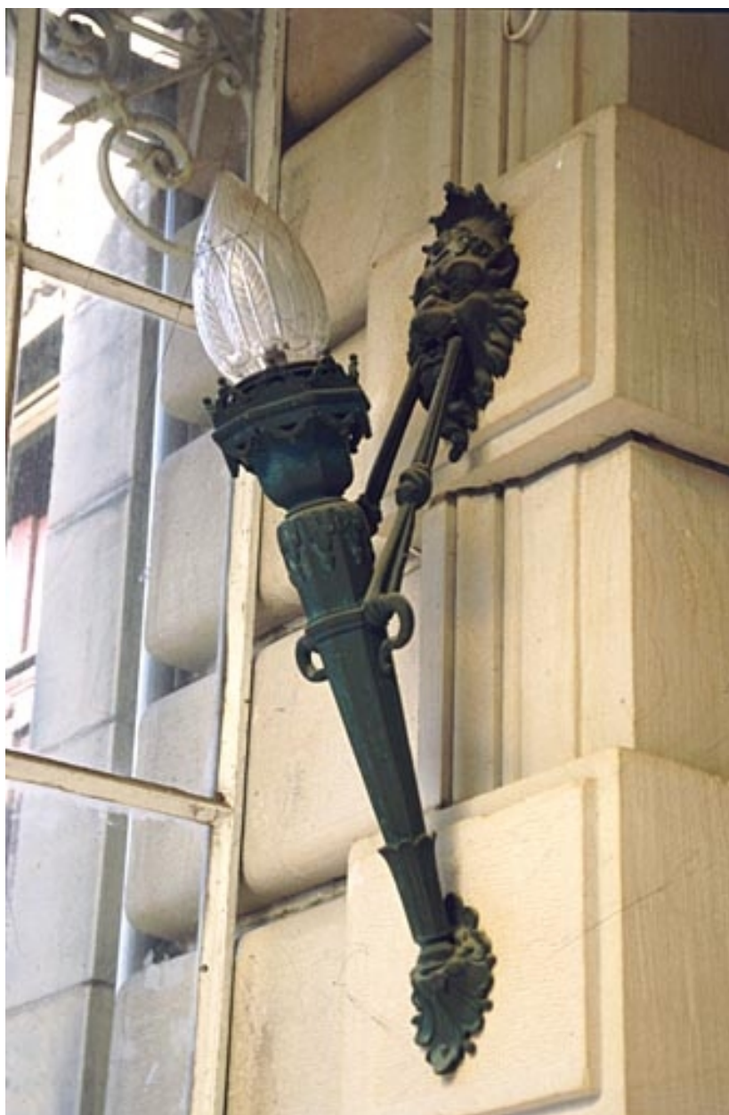
Façade antérieure : lampe d'applique.
