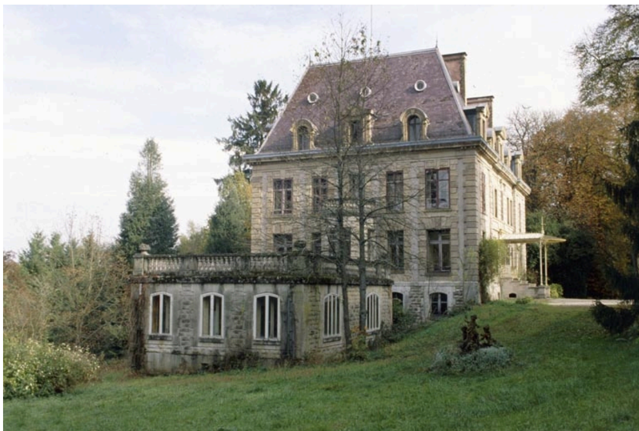
Vue depuis l'ouest.
