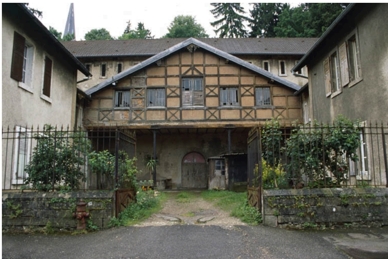
Façade nord de l'écurie.
