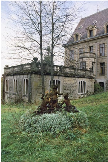
Extension de la demeure depuis le sud-ouest. Phot. Yves Sancey IVR43_20009000817ZA
