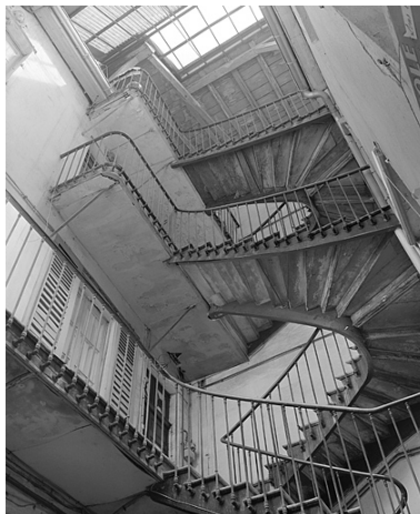
L'escalier, vue générale. Phot. Yves Sancey IVR43_19853900311X
