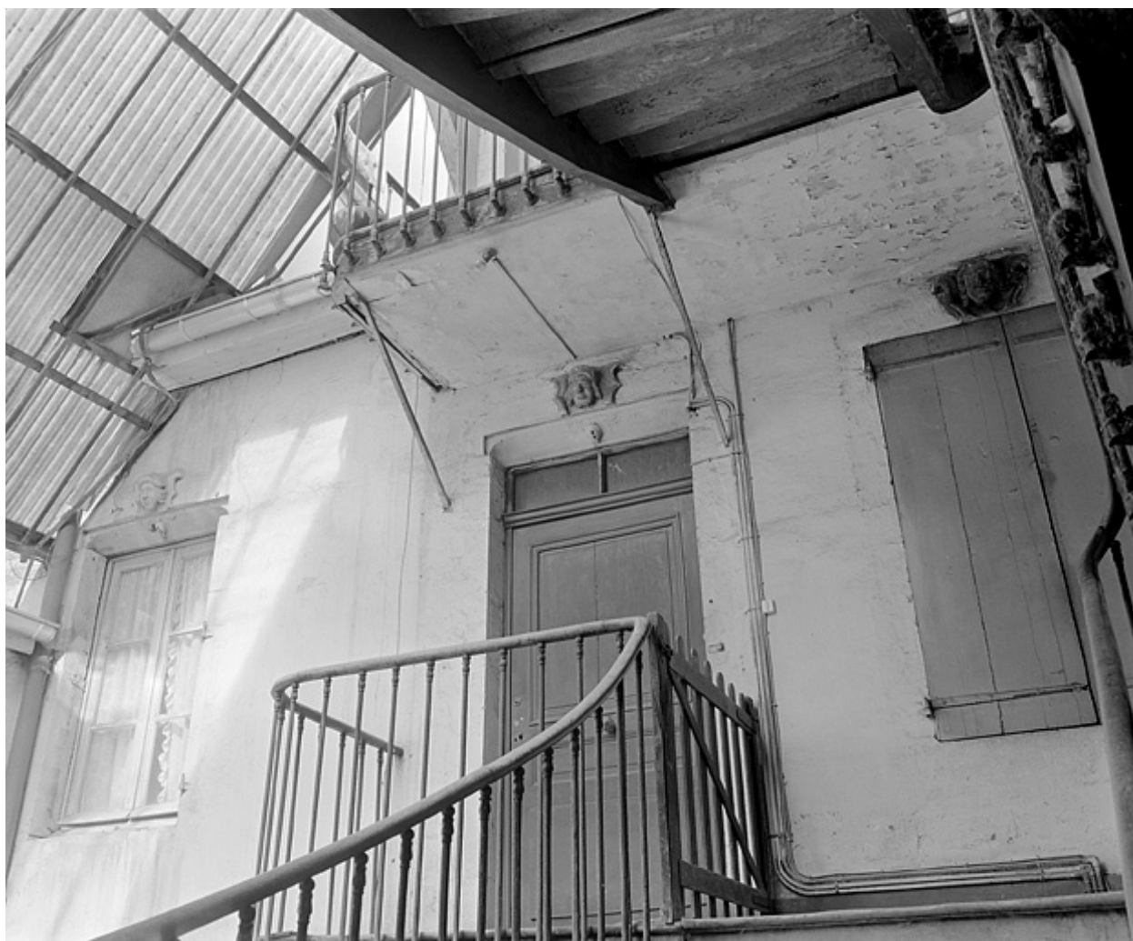
2e étage, élévation sur l'escalier.
