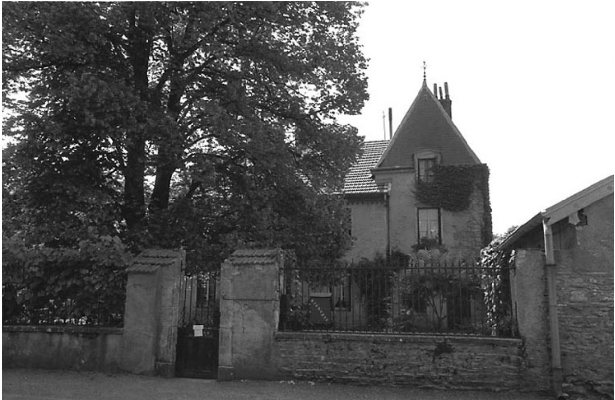
Vue d'ensemble depuis la rue.
