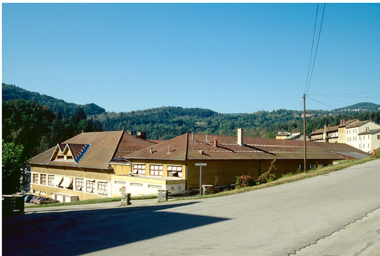
Nouvelle usine, vue depuis le nord-est.
