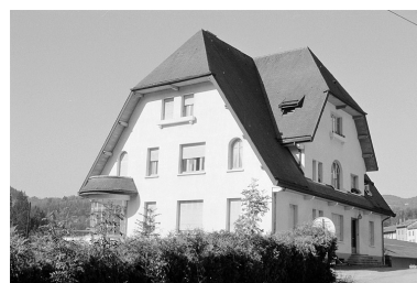
Logement patronal, de trois quarts gauche.
