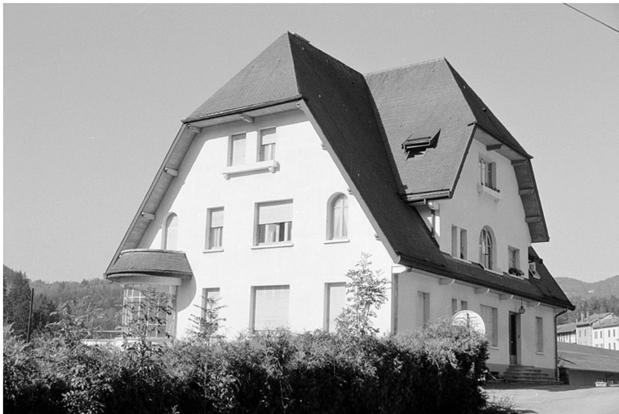
Logement patronal, de trois quarts gauche.
