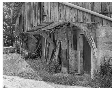
Galerie en bois protégeant un mur goutterot. Phot. Dominique Dominguez IVR43_19792500926X
