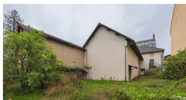
Façades postérieure et latérale gauche. Phot. Pierre-Marie Barbe-Richaud IVR26_20257100475NUC4A
