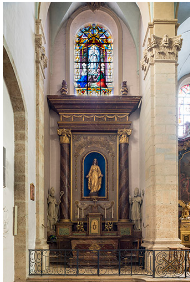
Baie de la chapelle du bas-côté nord : la Vierge de Lourdes. Phot. Jérôme Mongreville IVR43_20187000566NUC4A
