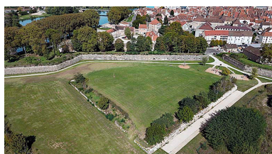
Le bastion sur la droite de l'image : son flanc et sa face.
