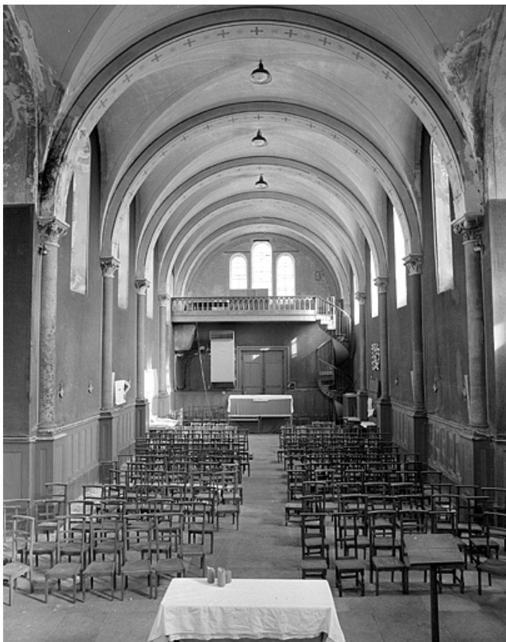
Vue intérieure de la chapelle.
