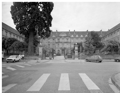
Vue d'ensemble sur la cour d'entrée.
