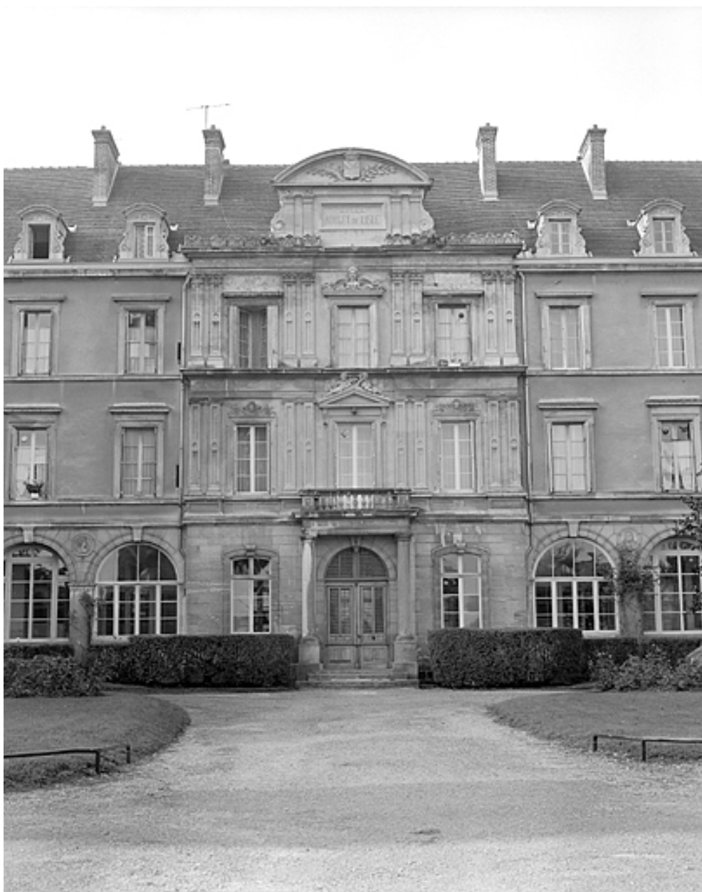
Façade antérieure, avant-corps central.
