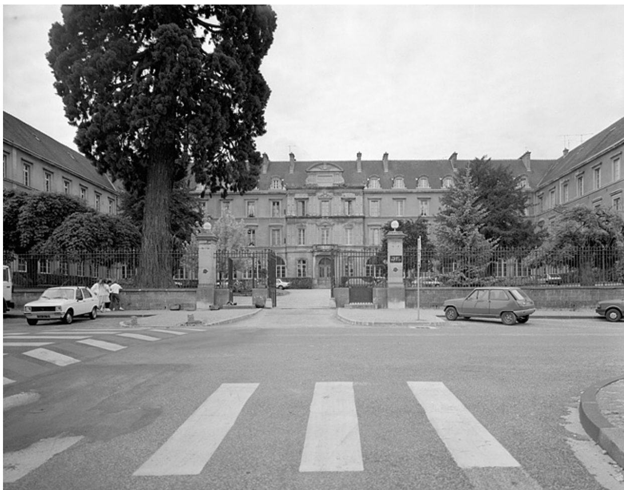
Vue d'ensemble sur la cour d'entrée.
