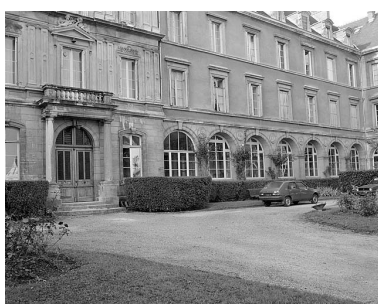
Façade antérieure, partie droite.
