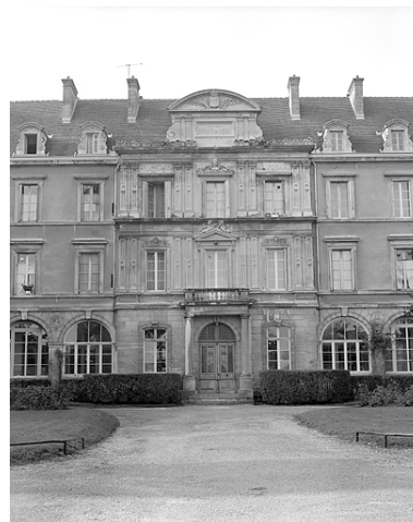
Façade antérieure, avant-corps central.
