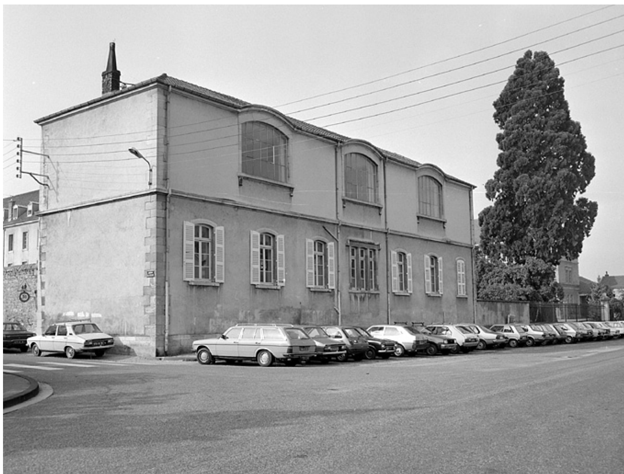
Bâtiment renfermant les salles de dessin.
