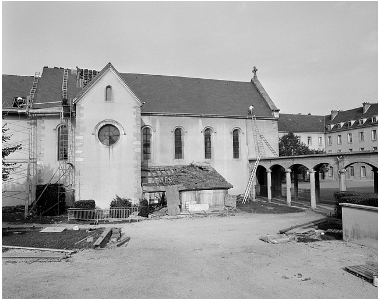
Façade antérieure de la chapelle.
