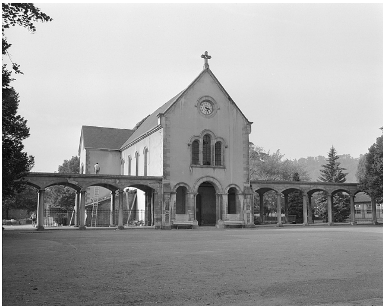
Façade antérieure de la chapelle et portique.
