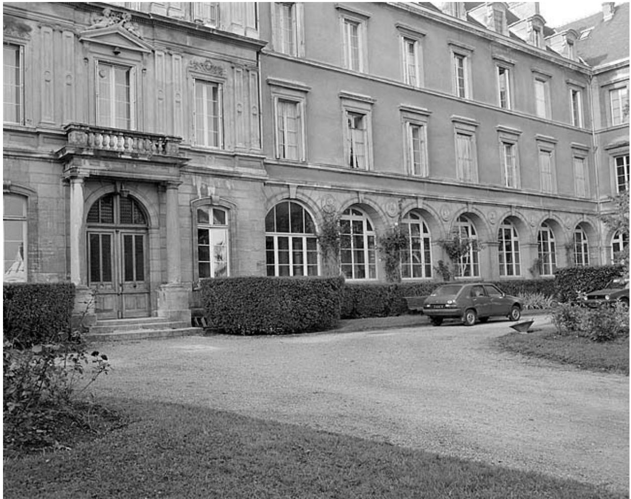
Façade antérieure, partie droite.
