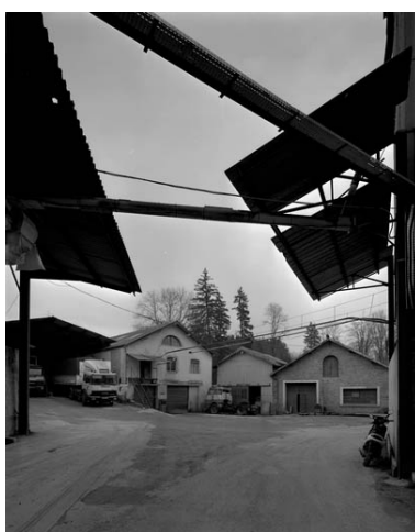
Magasins industriels et atelier de réparation. Phot. Jérôme Mongreville IVR43_19963900032V
