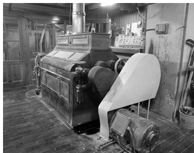
Appareil à cylindres Buhler. Phot. Jérôme Mongreville IVR43_19963900045X
