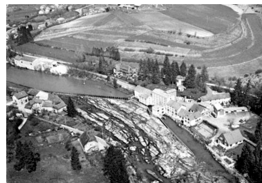
[Vue aérienne de la minoterie Sauvin]. Phot. Jérôme Mongreville IVR43_19963900160X
