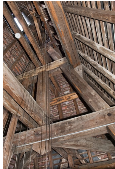
Les fils actionnant les cloches fixées au faîtage de la toiture. Phot. Jérôme Mongreville IVR43_20112502911NUC2A
