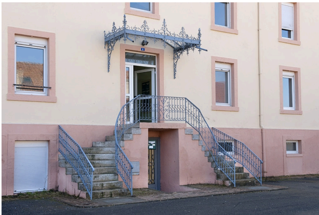
Façade antérieure. Entrée principale.
