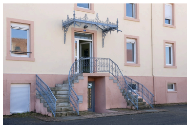
Façade antérieure. Entrée principale. Phot. Jérôme Mongreville IVR43_20122500177NUC4A
