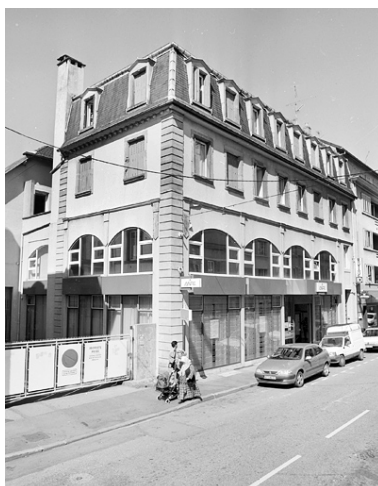
Vue de la façade sur la rue Thiers. Phot. Jérôme Mongreville IVR43_20029000162X
