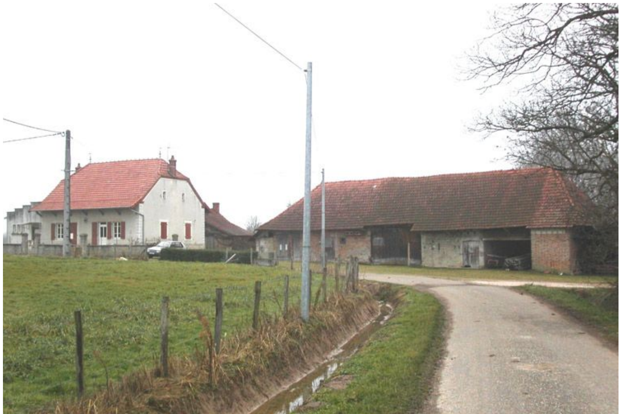
Vue d'ensemble de la façade.
