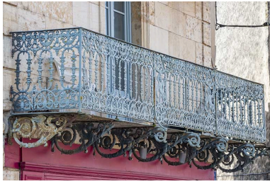
Le balcon du premier étage. Phot. Jérôme Mongreville IVR43_20227000049NUC4A
