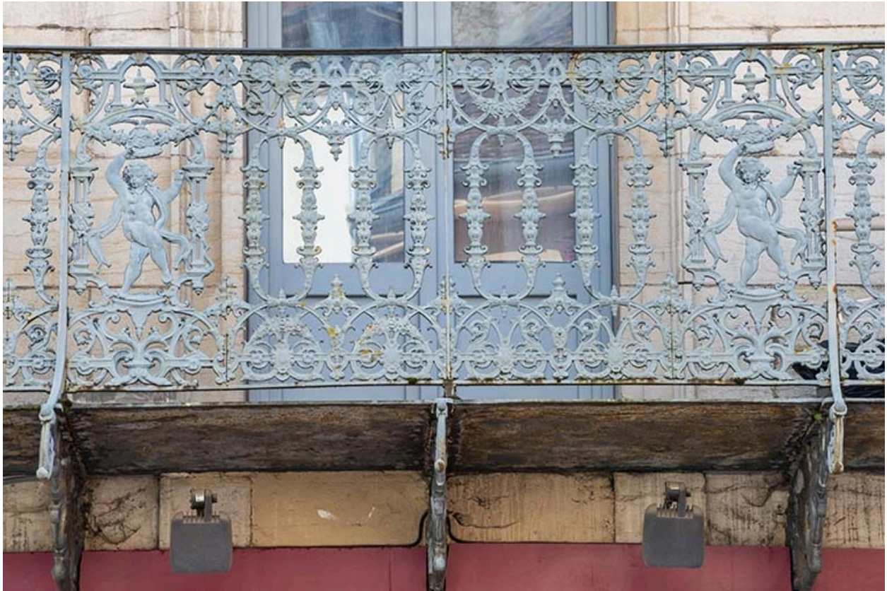
Détail du balcon du premier étage.
