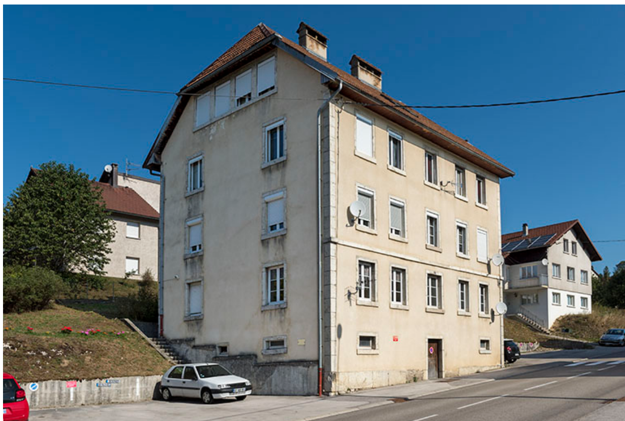
Façades antérieure et latérale gauche.
