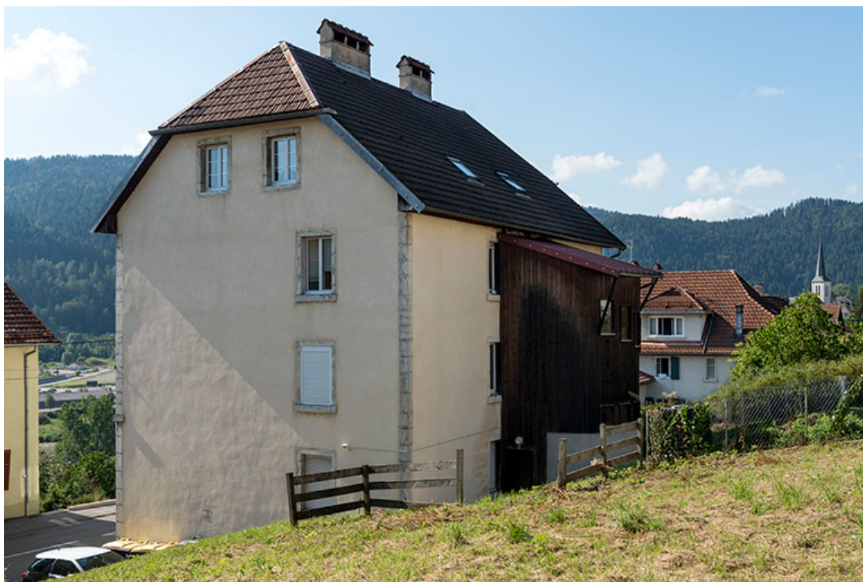
Façades postérieure et latérale droite.
