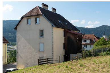
Façades postérieure et latérale droite.
