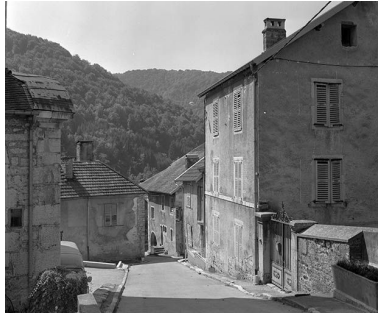
Face latérale gauche. Phot. Yves Sancey IVR43_19802500971X
